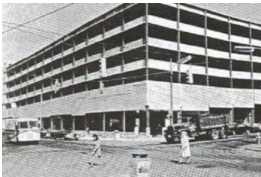
Figura 6 – Edifício garagem do experimento de Gewain et al. (1973).
