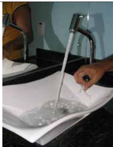
FOTO 31 –Torneiras sem redutor de vazão
