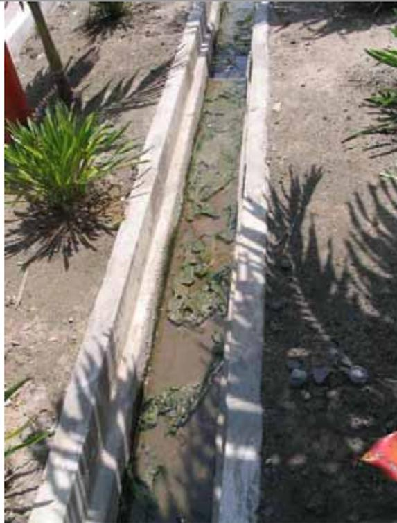
FOTO 13 - Sistema de drenagem em execução na área central de Porto de Galinhas
