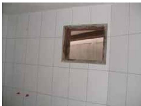
Abertura dos novos banheiros seria janela tipo “boca de lobo” e foi reformada para pivotante com abertura da totalidade do vão.
