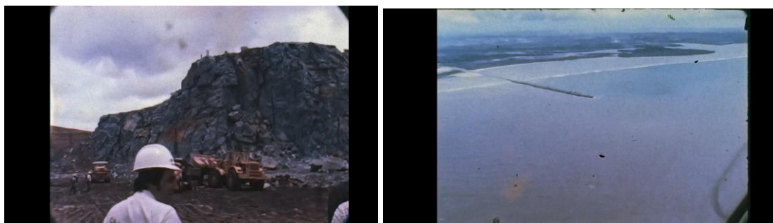
Figura 19 – A retirada das pedras (à esquerda) que irão compor o molhe do porto (à direita).
