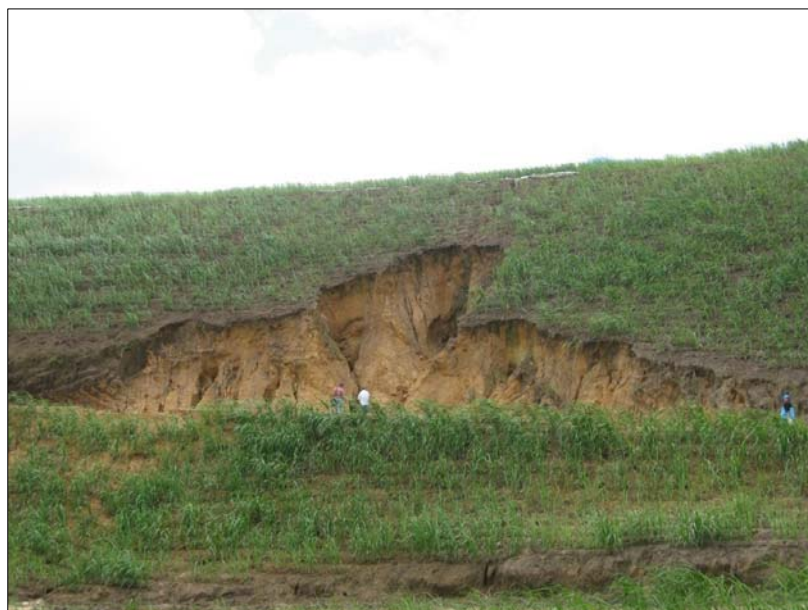
Foto 4.10 Voçoroca de grande porte em sedimentos da F. Barreiras (Coord: 286.258 E – 9.142.027 N)
