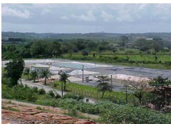
Figura 2 - Vista panorâmica da ETP-Muribeca
