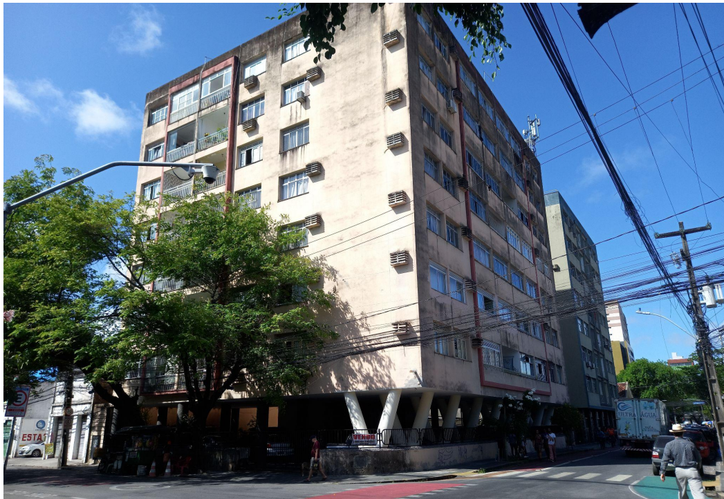
Imagem 32 - Edifício José de Alencar
