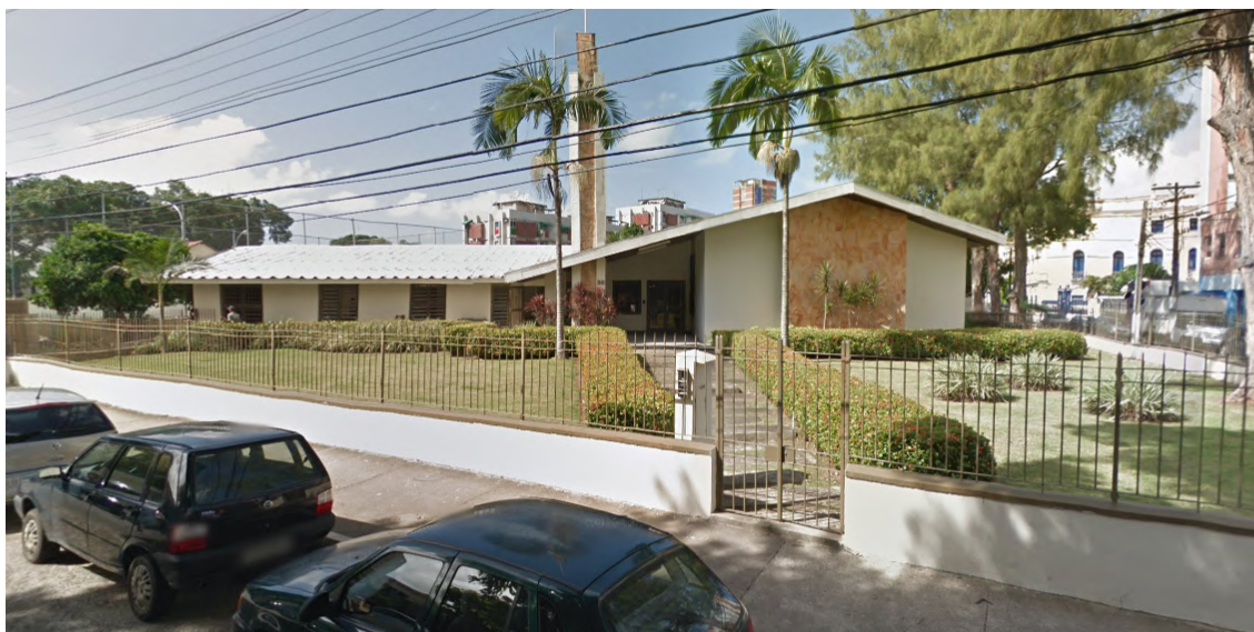
Imagem 23 - Edifício anterior à demolição
