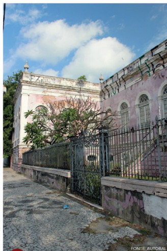
4 VISTA DA CALÇADA DO PORTÃO
