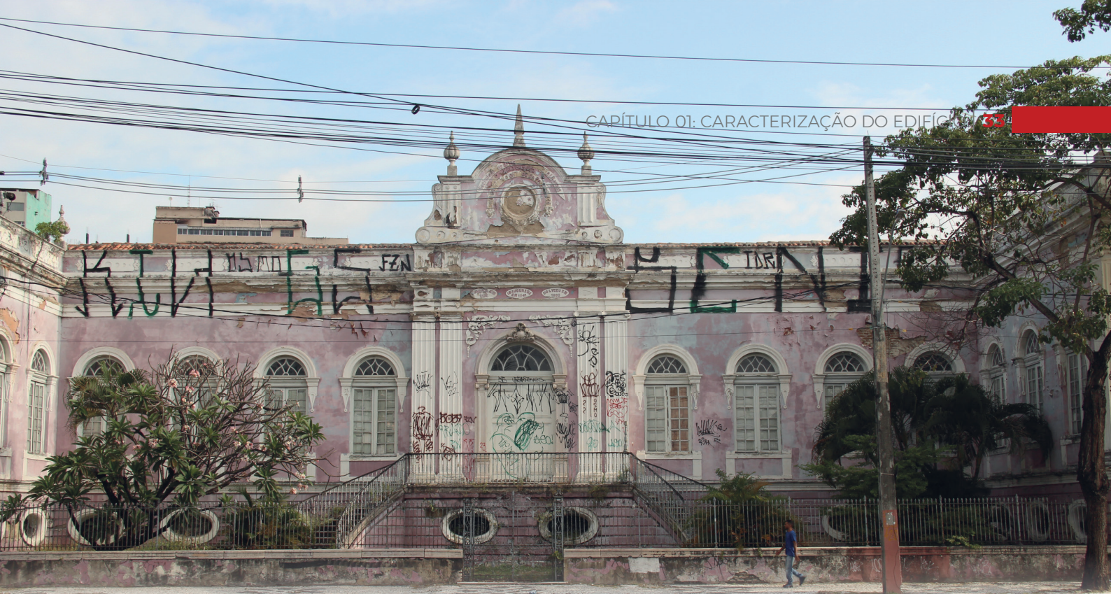
Figura 16 - Fotografia da Fachada Principal
