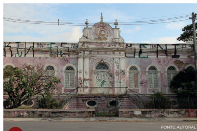
1 FACHADA PRINCIPAL DA EDIFICAÇÃO HISTÓRICA
