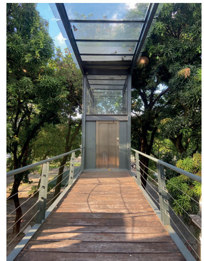
Figura 111 - Circulação Externa do Museu do Estado de Pernambuco
