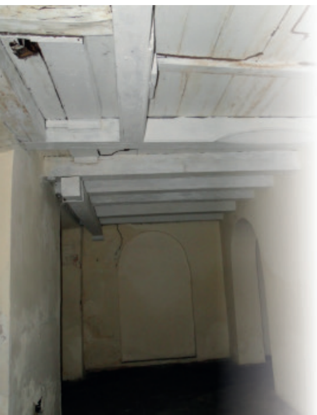
Figura 59 - Fotografia da Marcação da escada no vigamento do assoalho
