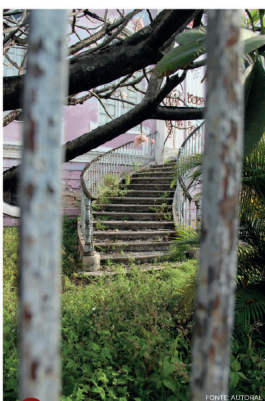
5 VISTA DA CALÇADA DA ESCADARIA
