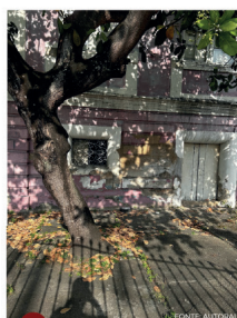
8 VISTA DO ACESSO AO PORÃO ALTO NA LATERAL
