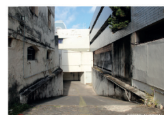
14 RAMPA DE ACESSO À CAIXA
