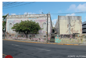
9 FACHADA LATERAL DA RUA DO SOL
