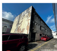
13 FACHADA POSTERIOR DO ANEXO EXISTENTE
