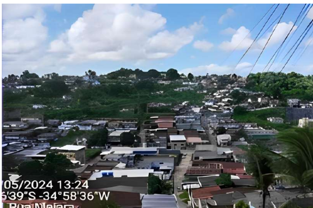
Figura 08- Encosta declivosa e proximidade com edificações
