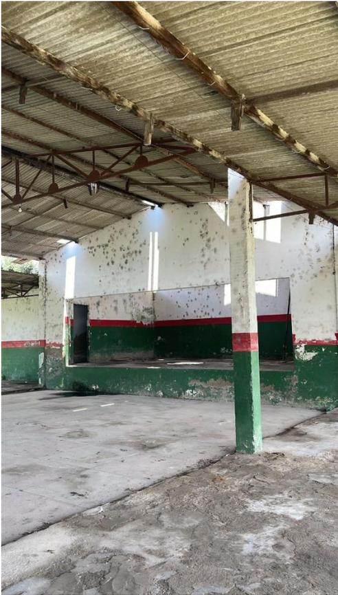
Figura 37 - Visão serial 3: Local coberto do Palmeiras e a defasagem na estrutura desgastada de madeira no telhado e mofo nas paredes, condenado pela infraestrutura local. Fonte: o autor, 2023.
