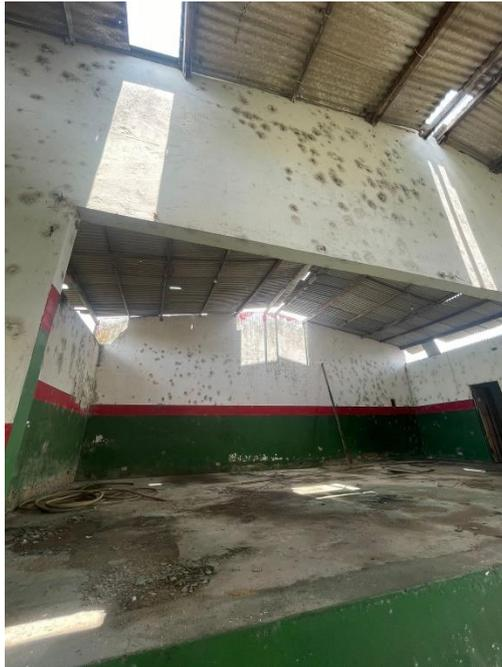
Figura 38 - Visão serial 4: Situação do antigo palco de alvenaria, onde apresenta risco de desabamento.
