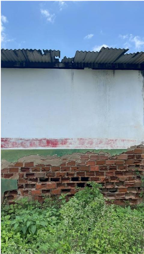
Figura 42 - Visão serial 8: Situação atual da parede posterior do palco desgastada pelo tempo e falta de manutenção. Fonte: o autor, 2023.
