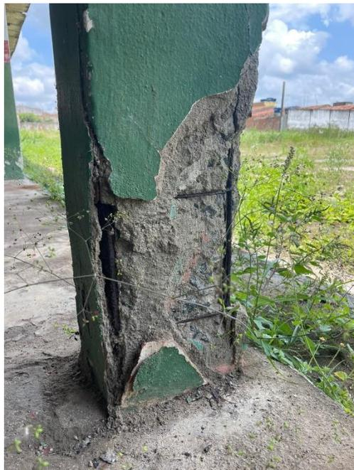
Figura 39 - Visão serial 5 Patologia estrutural na ferragem do pilar que sustenta a estrutura da área coberta do palco do palmeiras. Fonte: o autor, 2023.
