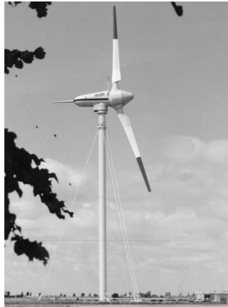
(b) Turbina eólica com torre de aço estaiada (diâmetro do rotor 100 m, potência nominal 3000 kW) do parque eólico Growian na Kaiser-Wilhelm-Koog, Alemanha, 1982.
