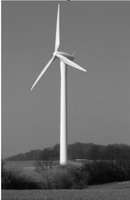
(a) Turbina eólica com torre tubular de aço (diâmetro do rotor 64 m, potência nominal 1500 kW).
