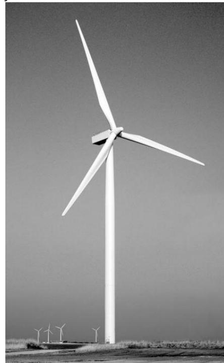
(b) HAWT: protótipo Bonus/Siemens Wind Power, (diâmetro do rotor 107 m, potência nominal 3,6 MW), 2005.
