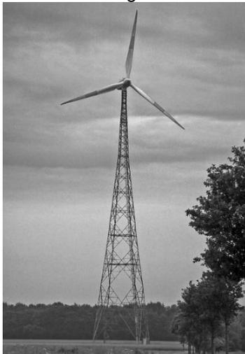
(a) Torre treliçada de uma turbina eólica Vestas V80 (diâmetro do rotor 80 m, potência nominal 2000 kW).
