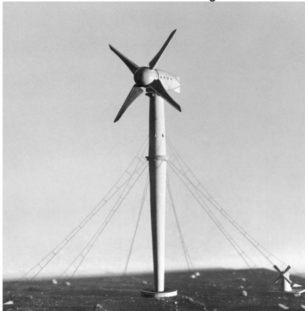
(a) Torre de aço estaiada de uma turbina eólica do projeto MAN-Kleinhenz (diâmetro do rotor 130 m, potência nominal 10 MW), 1942.
