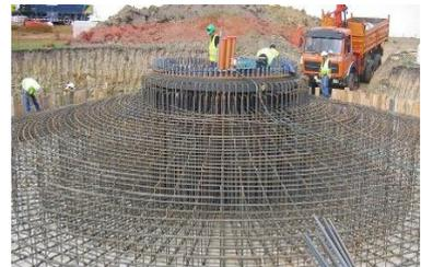
(i) Conexão parafusada do elemento de fundação.
