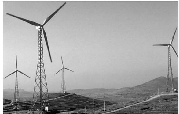
(b) Parque eólico Qingdao na China com turbinas eólicas Nordex N62 (diâmetro do rotor 62 m, potência nominal 1300 kW).
