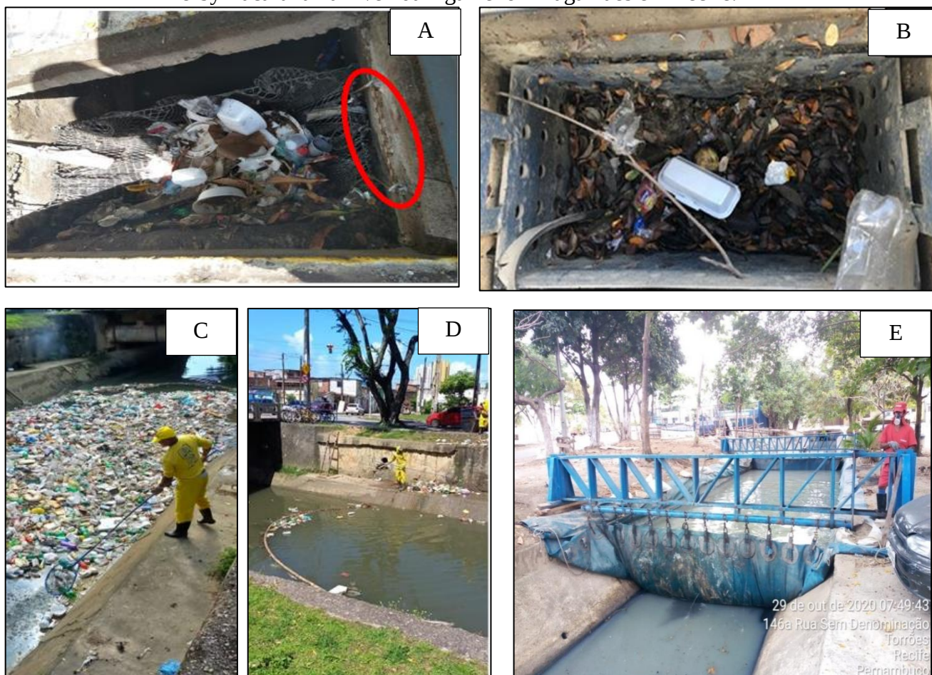
Figura 3 – Modelo do Ecocesto em PEAD (A) e Fibra (B) com material proveniente de descarte irregular; Ecobarreira em funcionamento com remoção dos resíduos (C) e finalização da limpeza (D) no Canal do Vasco da Gama (bairro Arruda) e Implantação da Barragem Móvel (E) no Canal Derby Tacaruna na Avenida Agamenon Magalhães em Recife.
