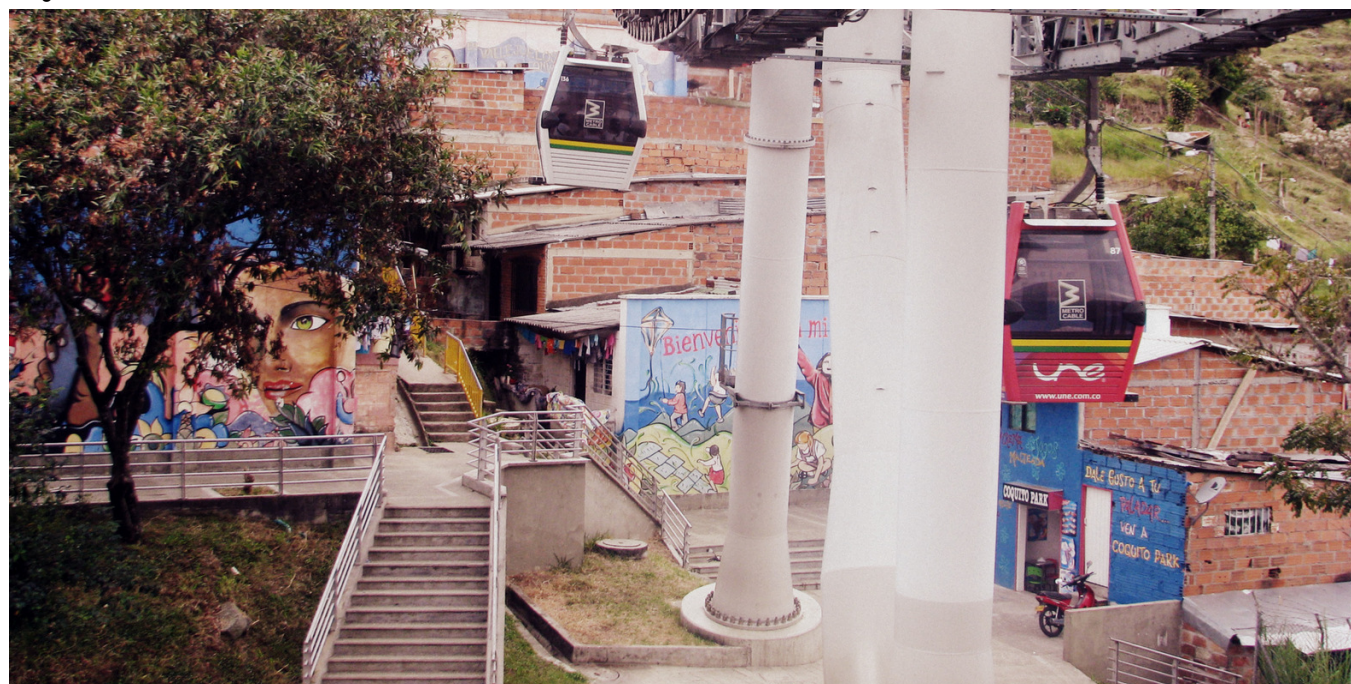
Figura 32: Intervenção em meio a moradias locais e o “metrocab”, sistema de transporte de média capacidade que conecta bairros e se integra ao metrô.
