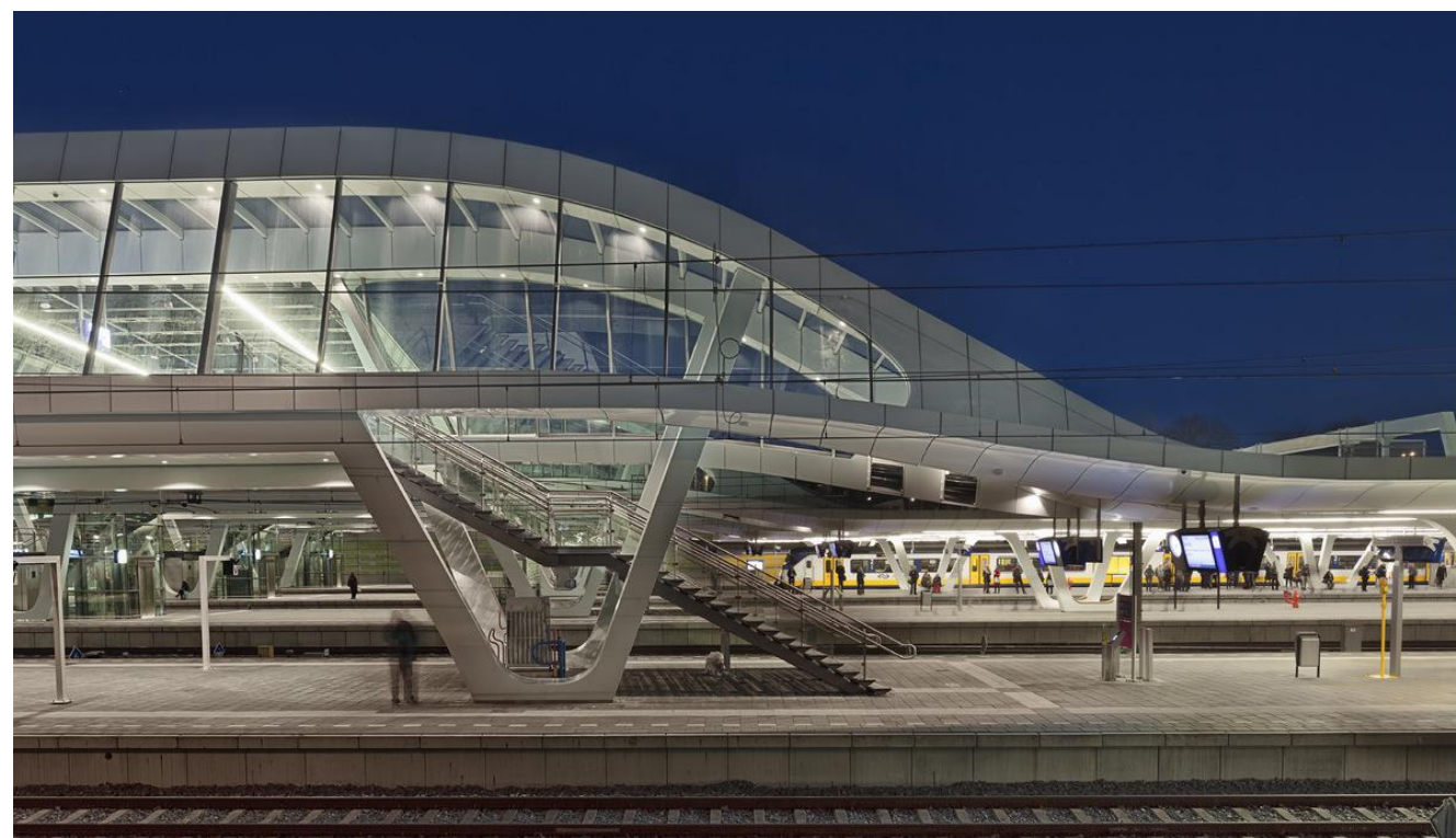
Figura 19: Plataforma de acesso ao trem.
