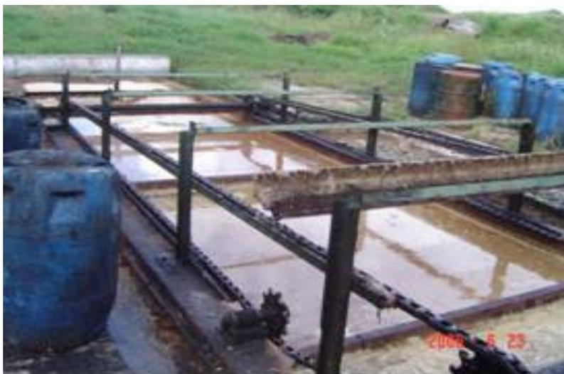
Figura 3.9 - Sistema de tratamento primário (Flotador por Ar Dissolvido) do abatedouro Serrote Redondo.
