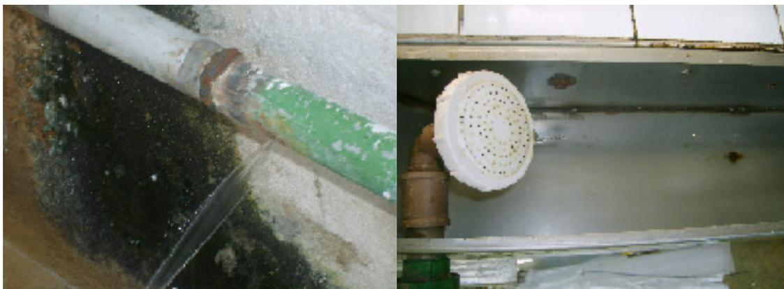
Figura 4.9 – Vazamentos por falta de manutenção
