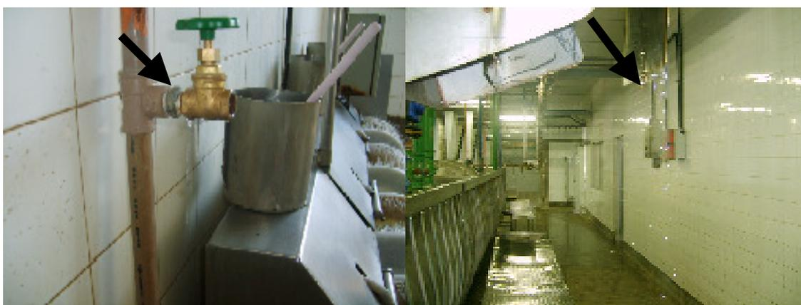
Figura 4. 10 – Vazamento por problemas em equipamentos.
