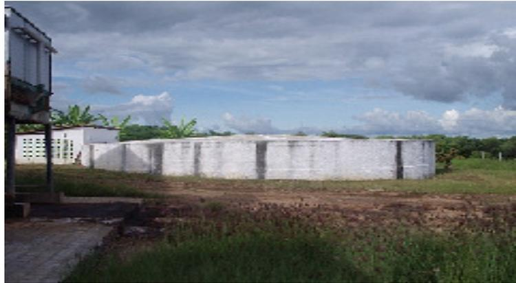
Figura 4.5 – Reservatório com capacidade para 2.000m<sup>3</sup> de água.
