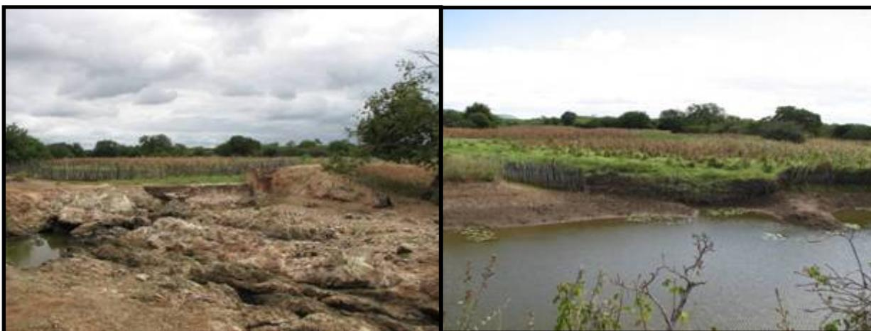
Figura 34: Paredão da barragem rompida e baixios formados à montante da barragem.
