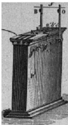
FIGURA 2.2. Modificação do projeto inicial da bateria de chumbo-ácido de Planté. Fonte: (KURZWEIL, 2010).
