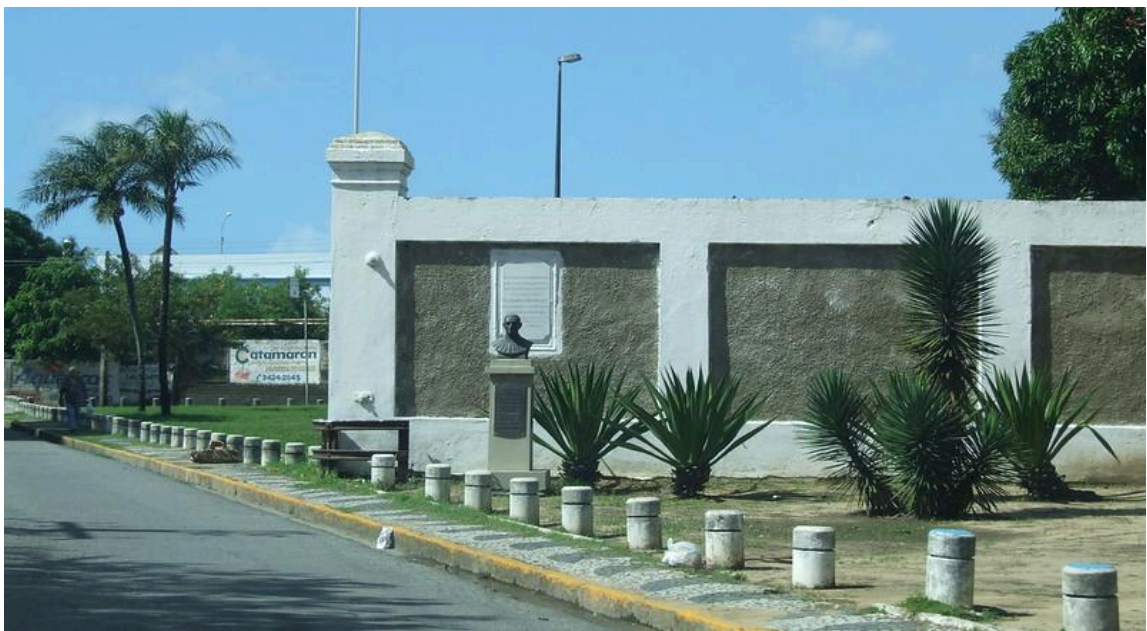
Imagem 36 - Muro do Forte de Cinco Pontas, local onde há placa alusiva ao suposto local do arcabuzamento de Frei Caneca
