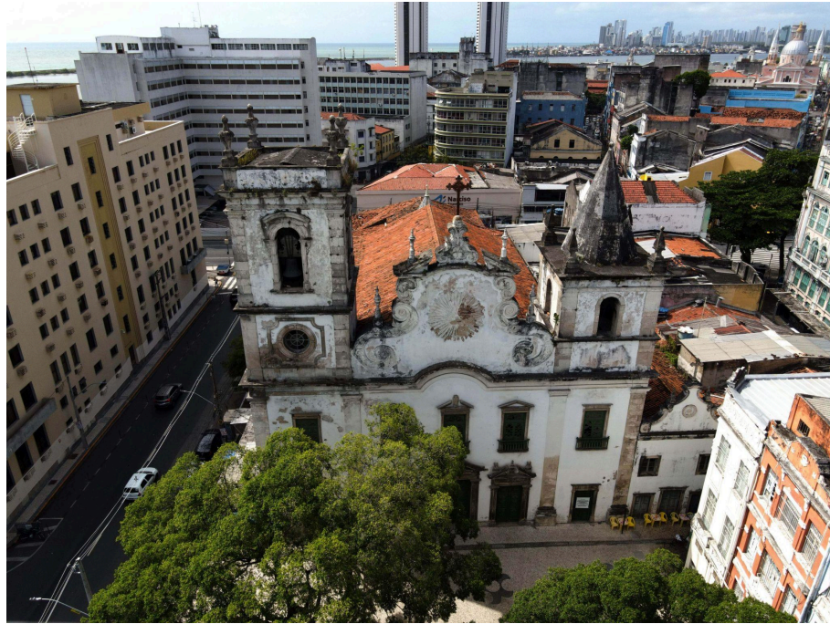
Imagem 21 - Vista da fachada da Igreja do Divino Espírito Santo
