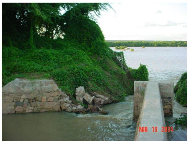
**FOTO 1:** P12 (AAT) - Detalhe comporta quebrada causando o deságüe do efluente sem tratamento no reservatório Delmiro Gouveia. Fonte: CHESF/COHIDRO, 2004
