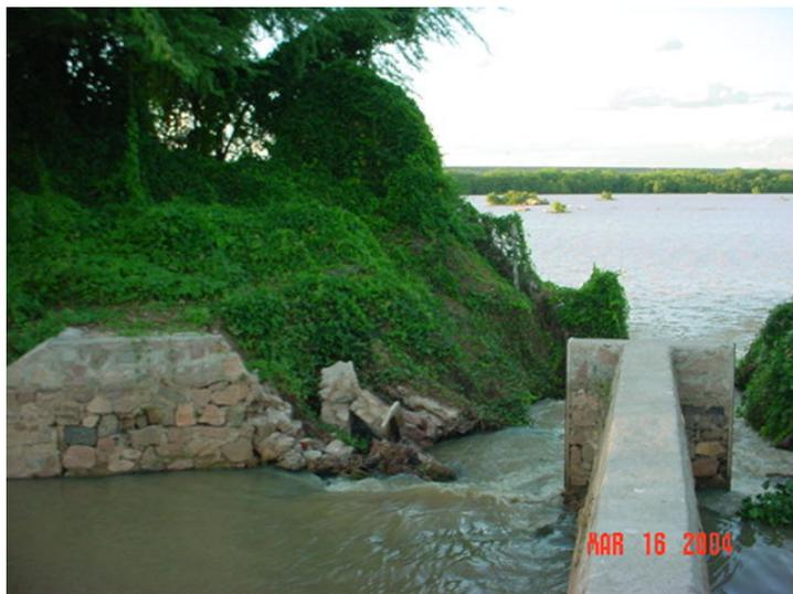
**FOTO 26:** P12 (AAT) - Detalhe comporta quebrada causando o deságüe do efluente sem tratamento no reservatório Delmiro Gouveia da Empresa AAT – Piscicultura por meio de Raceway. Fonte: CHESF/COHIDRO, 2004.
