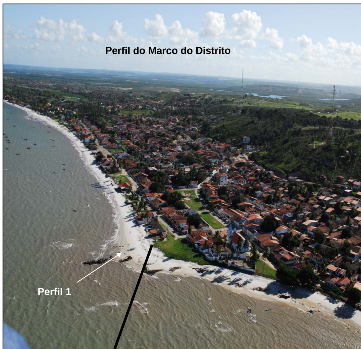
Figura 6.1 – Foto aérea do Perfil 1 Marco do distrito de Pontas de Pedra- Fonte CPRH – 2006
