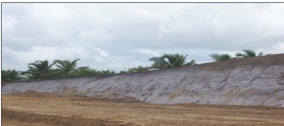
Figura 4.8. Ocorrência de neossolos no Município de Goiana - BR 101 Foto da autora - Fev / 2007
