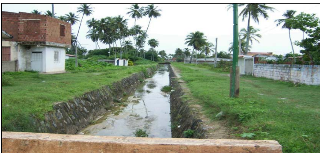
Figura 7.2. Maceió usado como galeria de águas servidas em Pontas de Pedra (foto da autora jul/2006).
