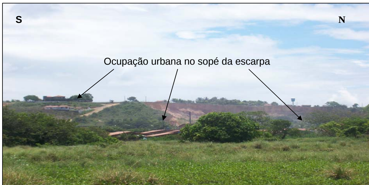
Figura 4.10. Ocupação urbana de falésias na localidade de Malvina (foto da autora mar/2006).
