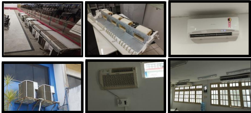
Figura 21 - Registros de Obras (Aesga)
