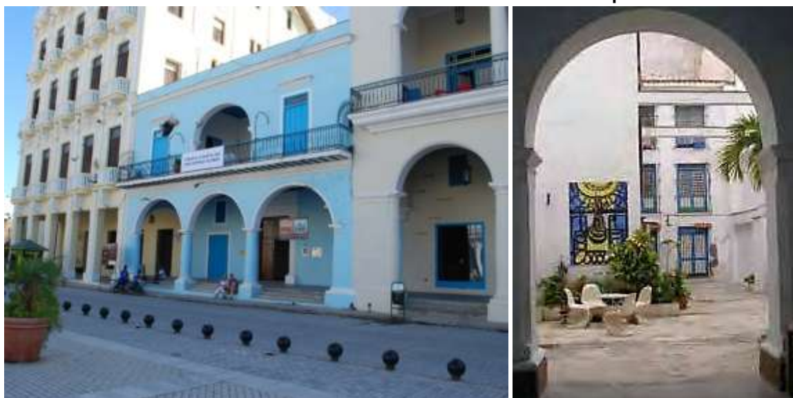
Imagen 84- Vista exterior e interior de la Casa de Beatriz Pérez Borroto después de la restauración. Nótese la inserción de nueva construcción al fondo del patio.
