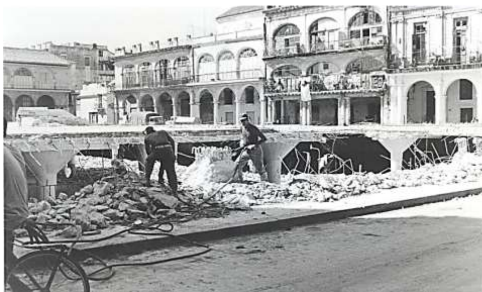
Imagen 118- Demolición del parqueo soterrado. Años noventa.
