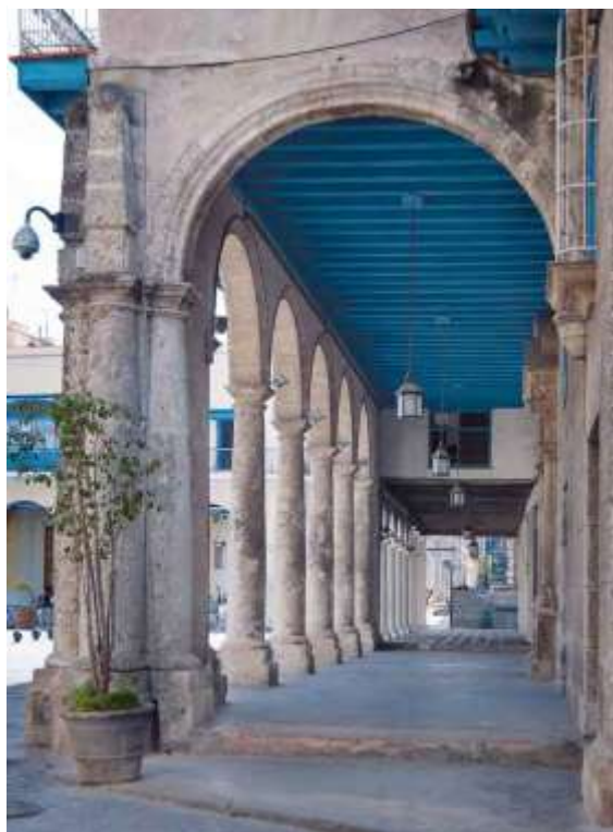
Imagen 103- Vista de la galería del portal con la piedra de Jaimanitas a la vista.
