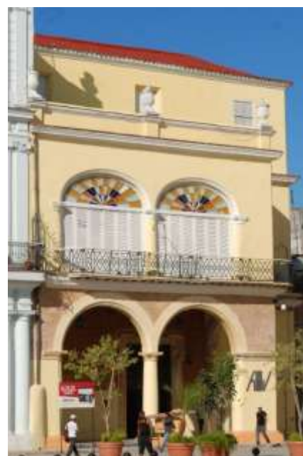
Imagen- 94 Casa de las Hermanas Cárdenas después de la restauración. Años ochenta.
