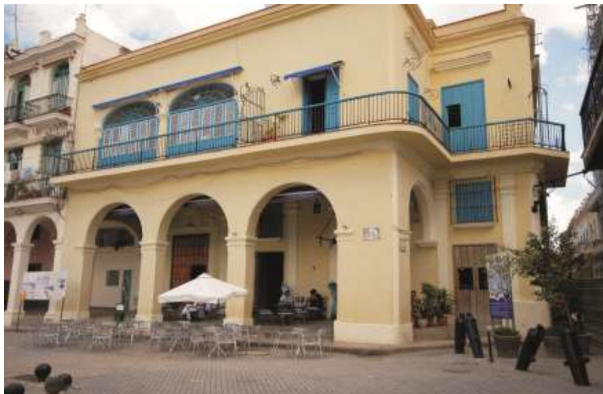
Imagen 86- Casa de Franchi Alfaro después de la restauración. Actualmente Café “El Escorial”.
