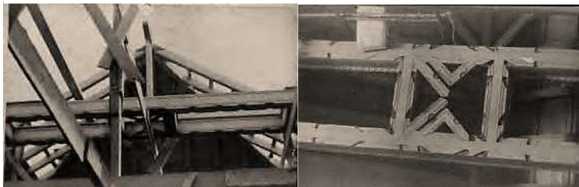
Imagen 101- Trabajos de restauración en el techo de armadura del salón principal. Detalle de uno de los tirantes antes de la restauración.
