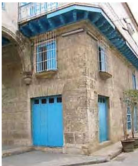
Imagen 102- Esquina modificada de la calle Muralla con Jaimanitas en los muros, despiezo similar al existente y carpintería de la época después de la restauración.
