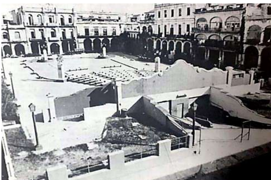
Imagen 76- Vista del Parque Habana con el Anfiteatro y la entrada del parqueo soterrado por la calle Muralla.
