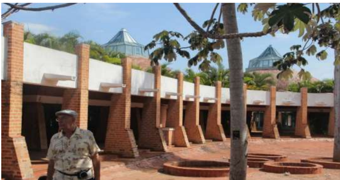
Imagen 21- El Arq. Augusto Rivero, que en su etapa de estudiante participó en la construcción de las Escuelas de Arte, ofreciendo una visita guiada en el interior de la Escuela de Artes Plásticas.
