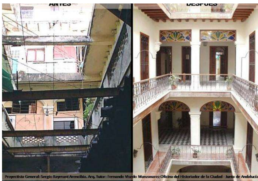
Imagen 81- Interior de “San Ignacio, 360”. Plaza Vieja. Obras terminadas en 2012.
