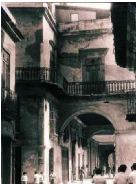
Imagen 108- Edificio del Colegio Santo Ángel como cierre de la calle Teniente Rey. Nótese el grado de deterioro del edificio.
