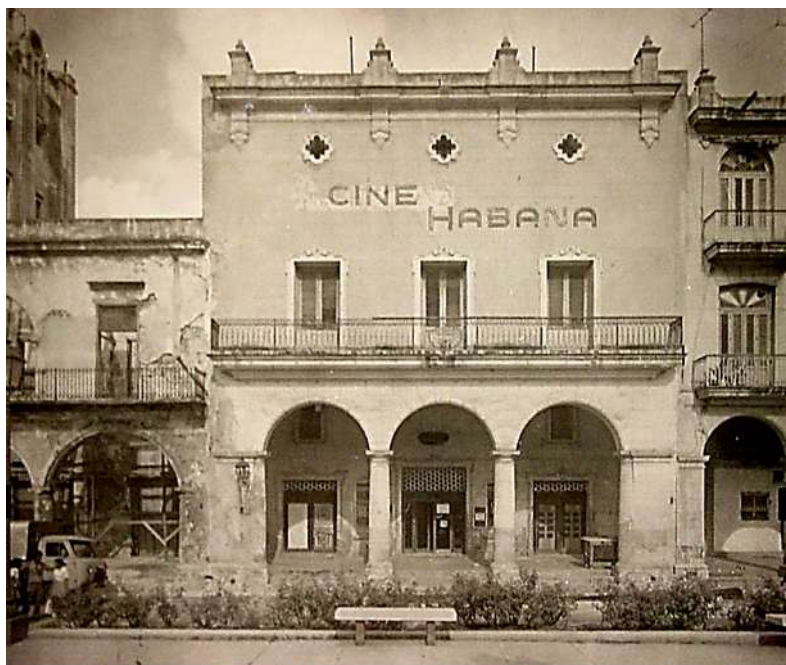
Imagen 104- Edificio del Cine Habana antes de la intervención.
