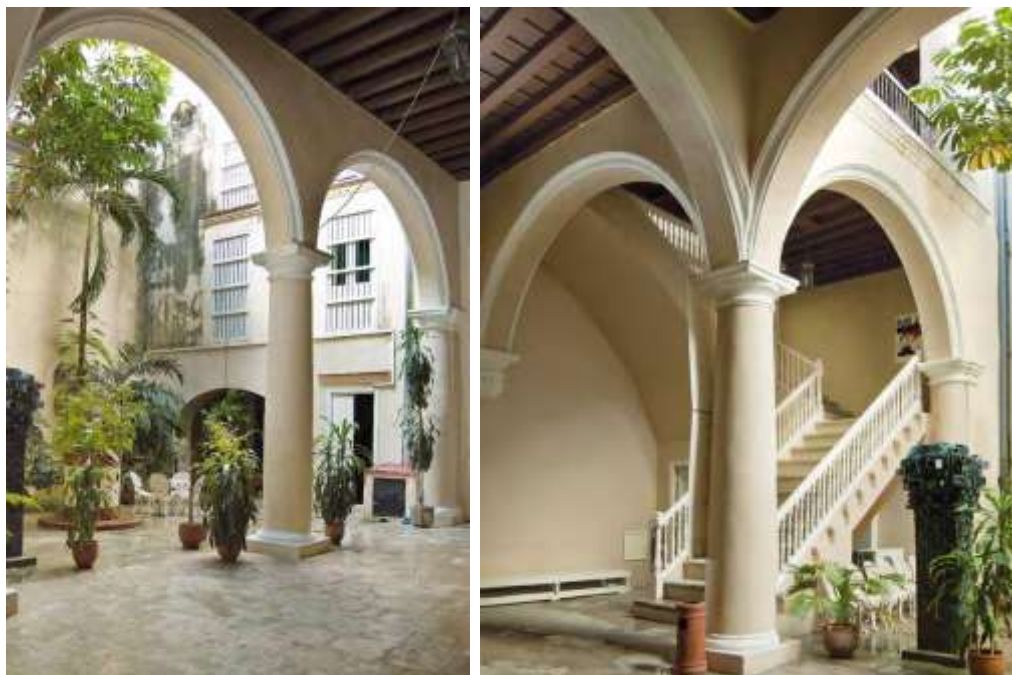
Imagen 95- Vistas del patio interior después de la restauración.
