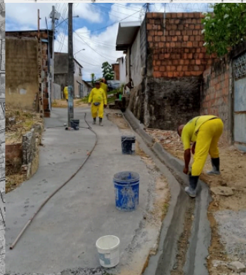
Figuras 90 e 91: Obra de drenagem, escadaria e corrimão, por meio do Programa Parceria no Alto da Bela Vista (ZEIS Ibura).
