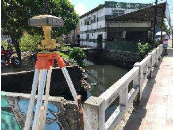
(c) Levantamento de altitudes ortométricas e nivelamento geométrico do ponto de monitoramento.
