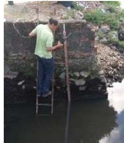
(d) Instalação das réguas linimétricas.
