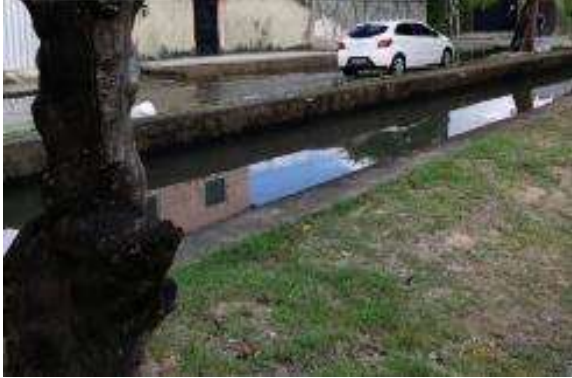
Figura 8 - Acúmulo de água nas vias locais em dias sem chuva.
