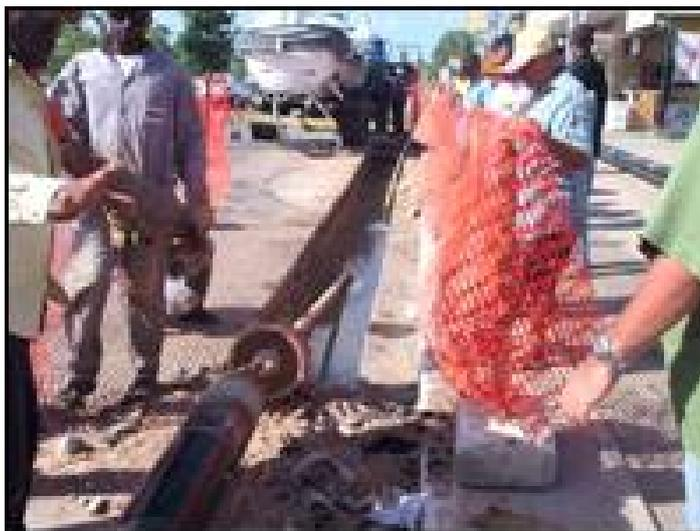
*Figura 3.10 – Método não destrutivo: o escarificador atado ao tubo entrando na janela*
