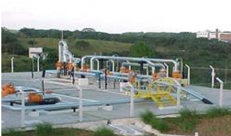
*Figura 3.7 – Estação redutora de pressão (ERP)*
