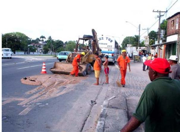
*Figura 3.16 - Método Não Destrutivo – Finalização do conserto do rompimento do asfalto*
