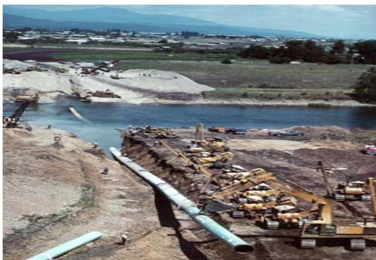
*Figura 3.6 – Método Destrutivo: travessia de curso d'água*
