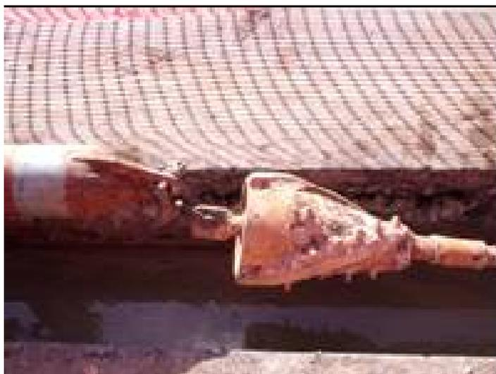
Figura 3.11 - Método não destrutivo: detalhe do escarificador atado ao tubo
