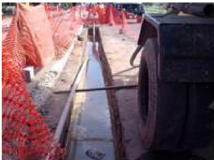
Figura 3.9 – Método não destrutivo: janela aberta
