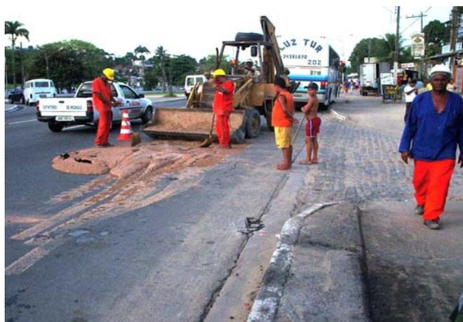
*Figura 3.15 - Método Não Destrutivo – Início do conserto do rompimento do asfalto*
