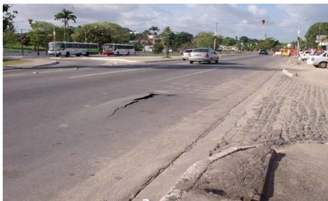
*Figura 3.13- Método Não Destrutivo – Rompimento do asfalto pela pressão do lubrificante*
