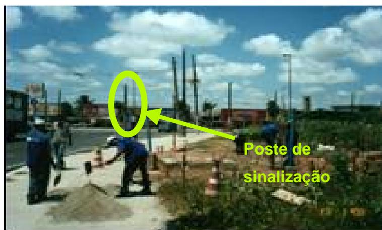
*Figura 3.5 – Método destrutivo: recomposição da área e sinalização de existência de gasoduto*
