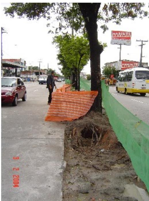
*Figura 3.3 - Método destrutivo: vala abertura*
