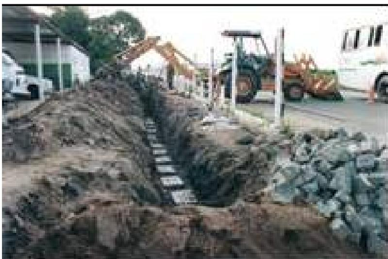
*Figura 3.4 – Método destrutivo: placas de cimento usadas como dispositivo de proteção e indicação*
