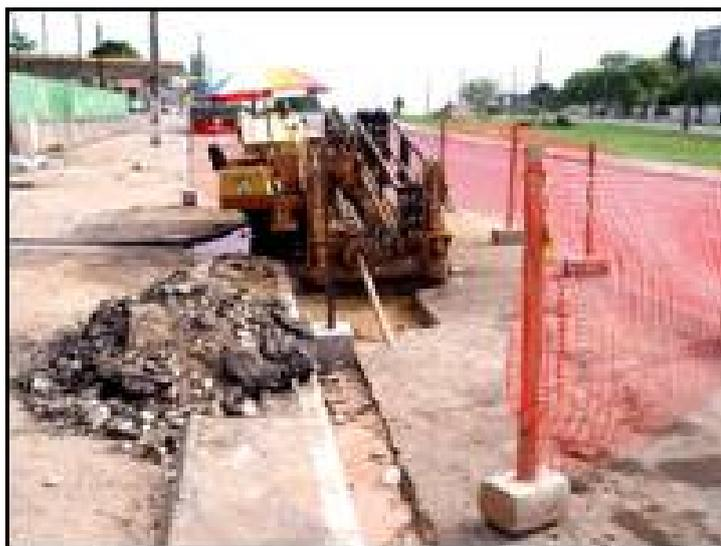
Figura 3.8- Método não destrutivo: máquina de tração
