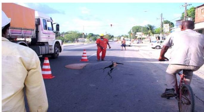
*Figura 3.14 - Método Não Destrutivo – Isolamento da área de rompimento do asfalto*
