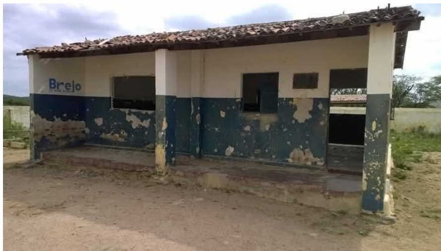
Escola Municipal Nossa Senhora do Desterro – Sítio Tambor/ Início da reforma
