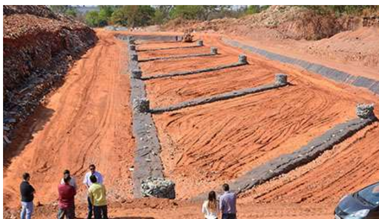
Figura 4. Sistema de drenagem do aterro de Aparecida de Goiânia-GO.
