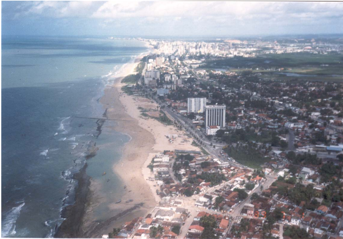
Figura 14: Visão geral do setor 1, onde se destaca a configuração assumida pela Av. Boa Viagem que sofre uma grande inflexão nas imediações da Rua do Atlântico, passando da direção 25° Az para 13° Az. Foto: Maia Melo Engenharia, 1989.
