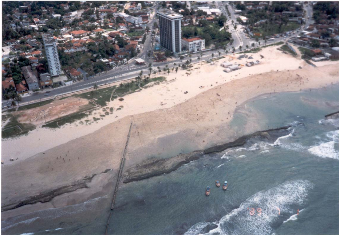
Figura 19: Detalhe da deposição sedimentar junto ao antigo emissário submarino do Pina, provocada pelo transporte longitudinal de sedimentos no setor 1, onde nota-se claramente o sentido do transporte litorâneo. Fonte: Maia Melo Engenharia, 1989.
