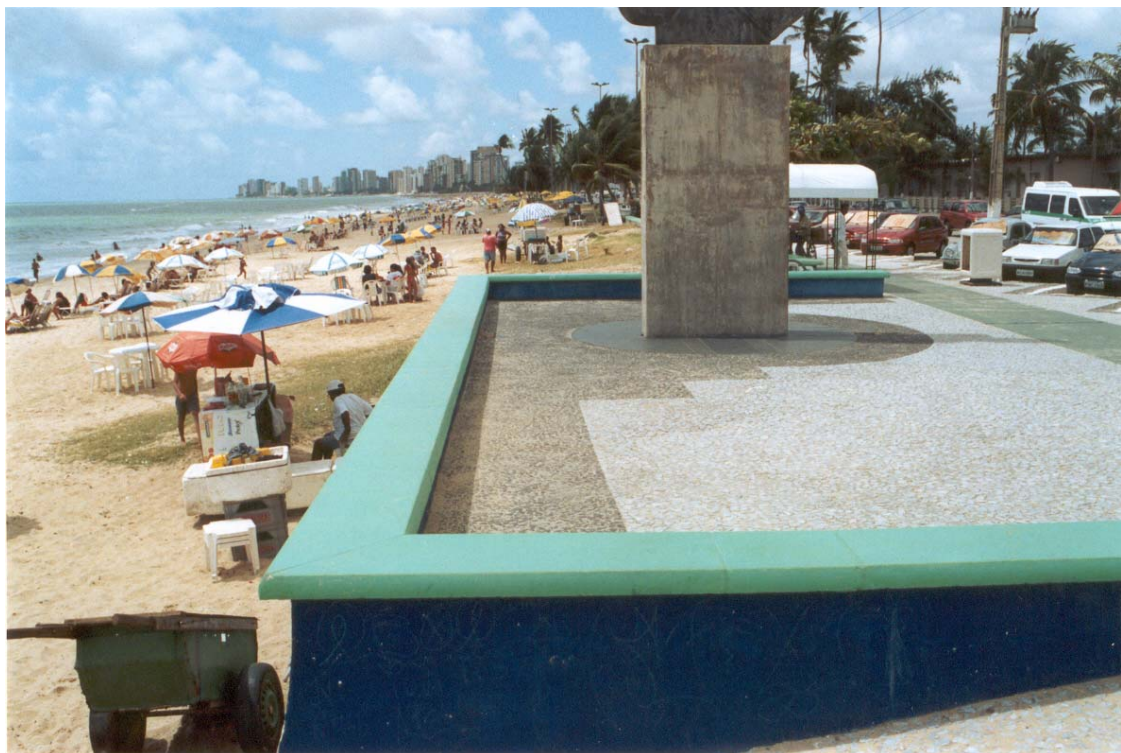
Figura 38: Exemplo de intervenção inadequada na faixa de praia do setor 4. Nota-se a ocupação de quase toda a pós-praia por uma estrutura fixa que acaba por promover a impermeabilização deste trecho do perfil praial. Foto do autor.
