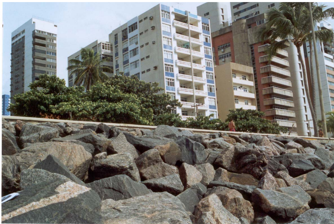
Figura 34: Visão parcial do enrocamento da Av. Boa Viagem no setor 3. Destaca-se o grande volume de rocha que atualmente ocupa área da antiga faixa de praia (comparar com a figura 22). Foto do autor.
