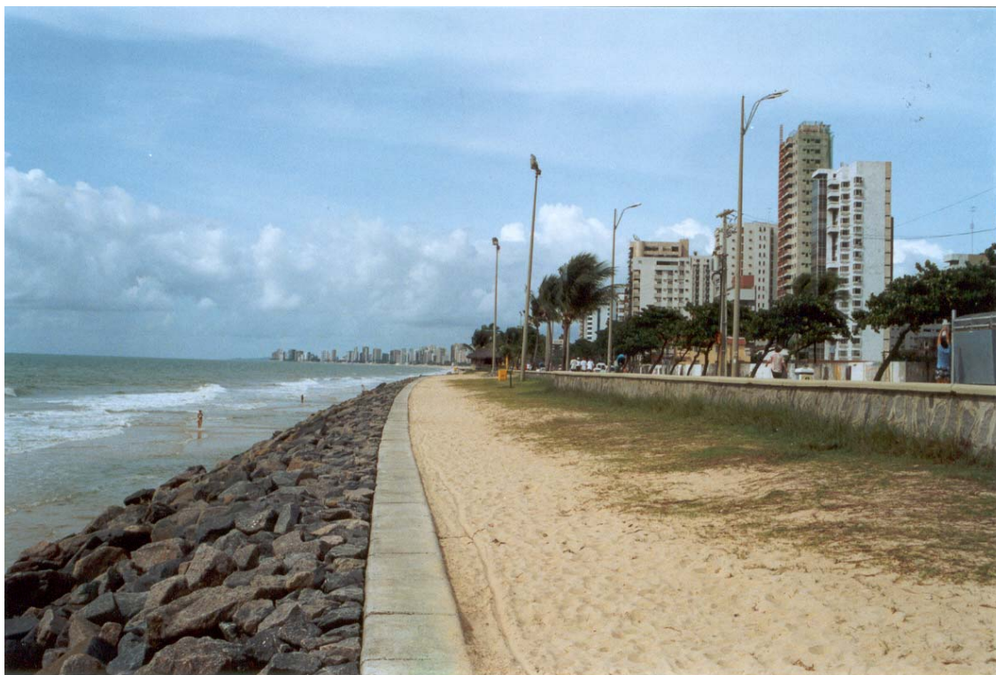
Figura 32: O mesmo trecho de praia da figura 31 no início do ano de 2002. Nota-se um profundo rebaixamento da superfície da praia e a supressão completa da pós-praia. Apresenta-se como uma área de grande risco à conservação da Av. Boa Viagem. Foto do autor.
