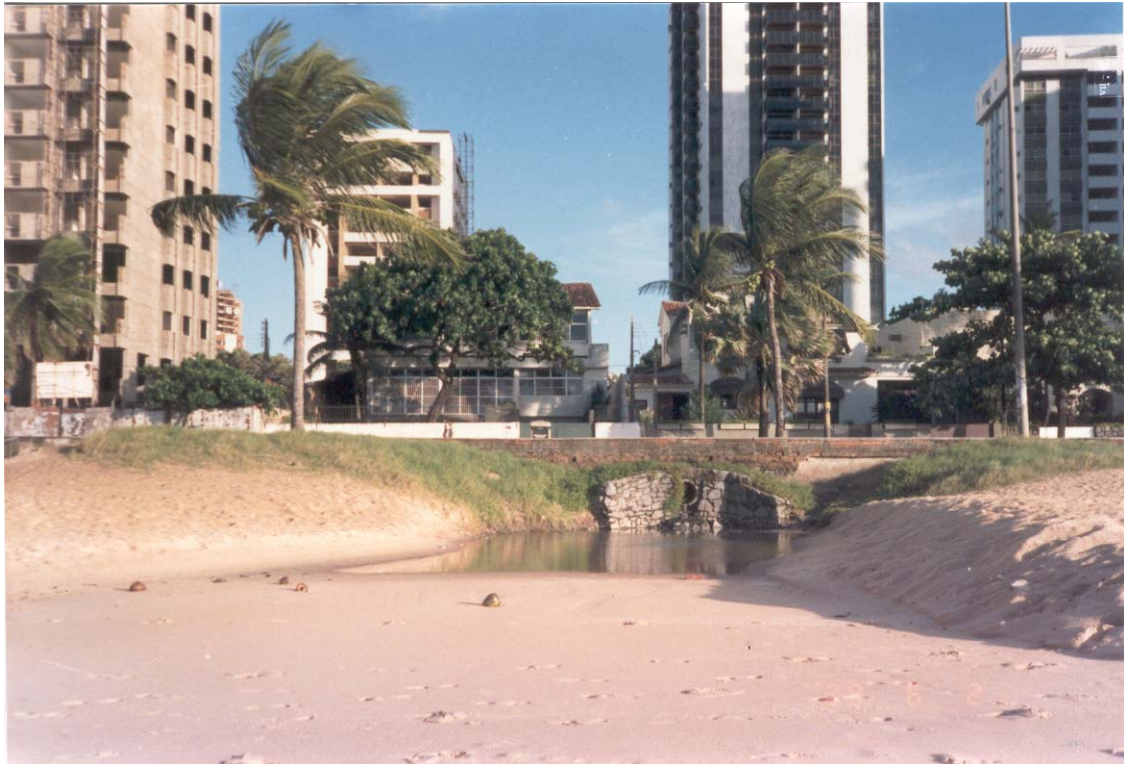
Figura 21: Aspecto geral do trecho de praia em frente à Rua Bruno Veloso, onde uma galeria de águas pluviais provoca um rebaixamento acentuado do terreno da praia. Fonte: Maia Melo Engenharia, 1989.
