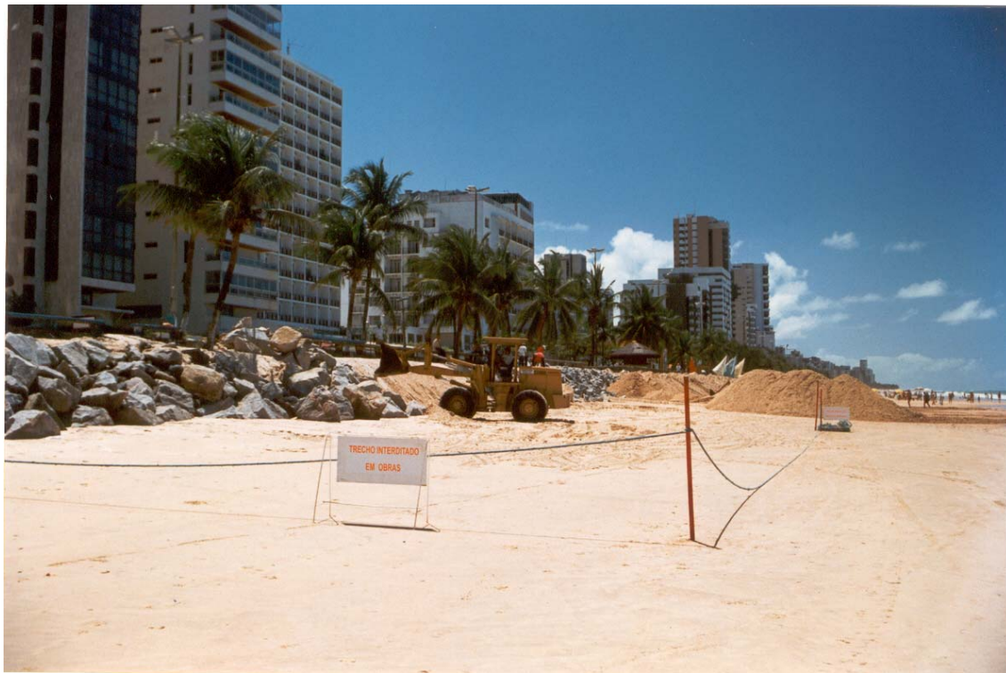
Figura 30: Obras de construção do enrocamento da Av. Boa Viagem (próximo ao Hotel Boa Viagem). Foto do autor.
