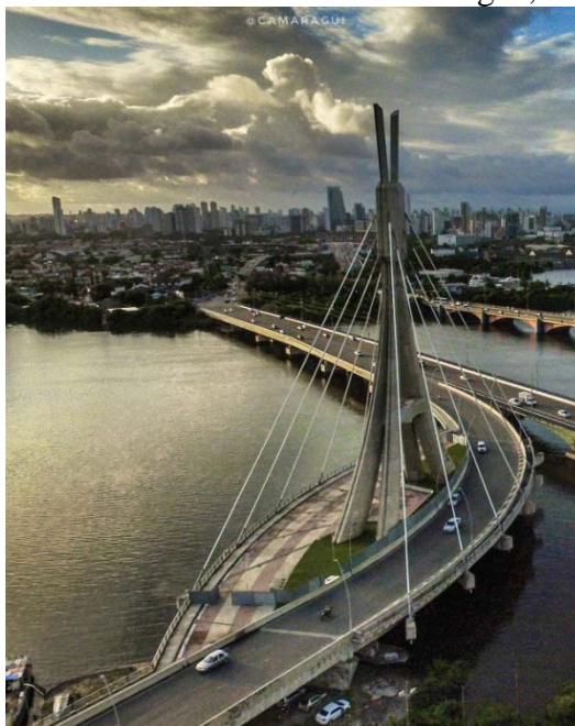
Figura 9 - Ponte estaiada da Via Mangue, Recife
