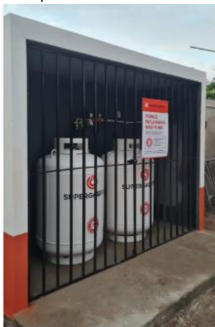
Figura 2 - Exemplo de central de GLP - Fonte: O autor
