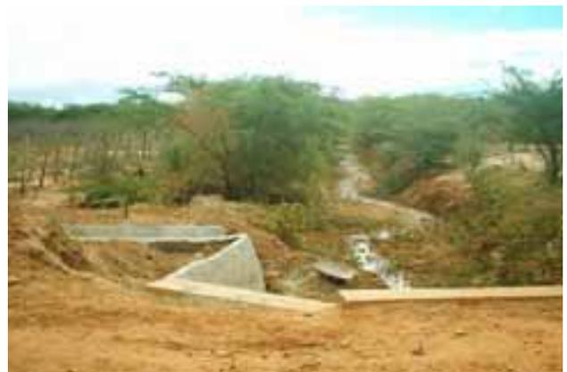
**Figura 64:** Sistema de drenagem do projeto Icó-Mandantes descarregando os excedentes da irrigação no lago de Itaparica, Petrolândia, PE.
