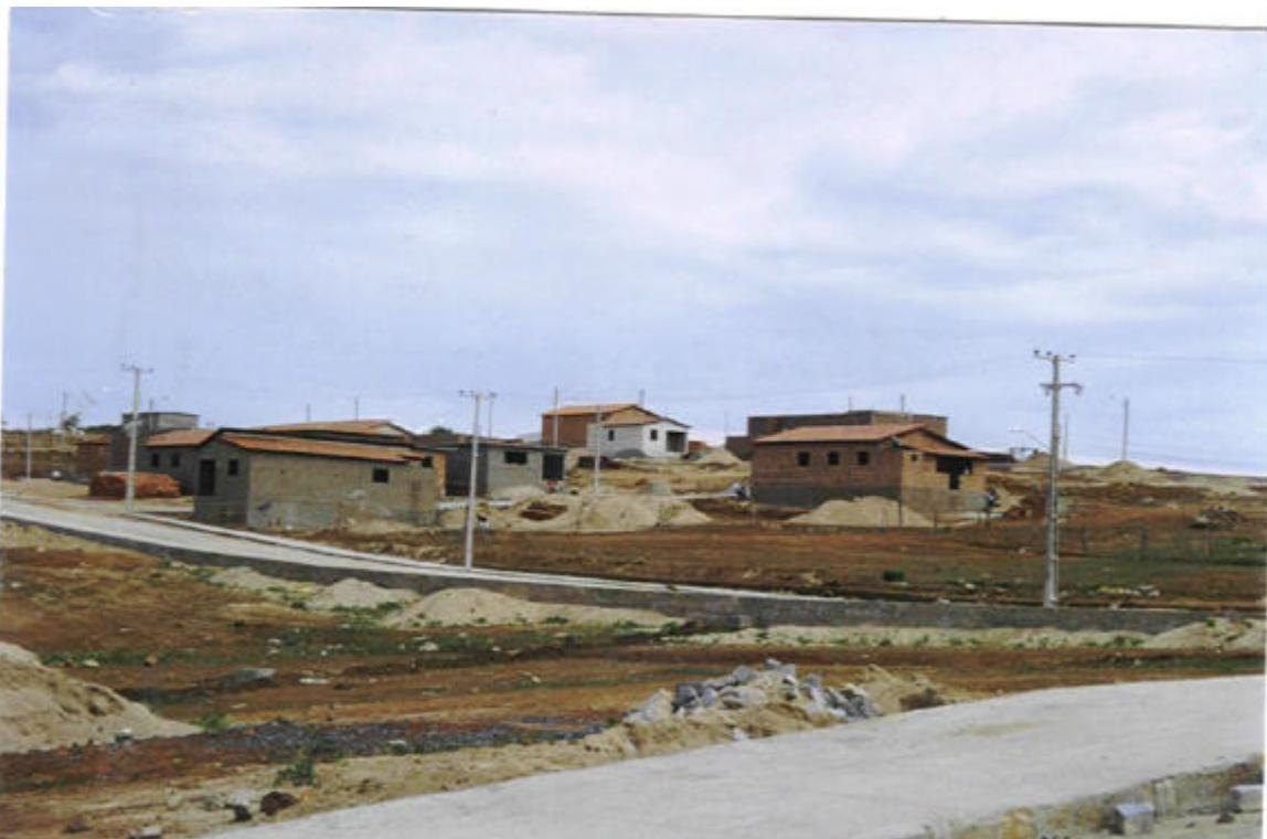
Foto: 15 – Reassentamento da Vila Trapiá – Riacho das Almas/PE. Construção de residências, implantação de infra-estrutura (energia elétrica, saneamento e vias de acesso). (DNOCS)
