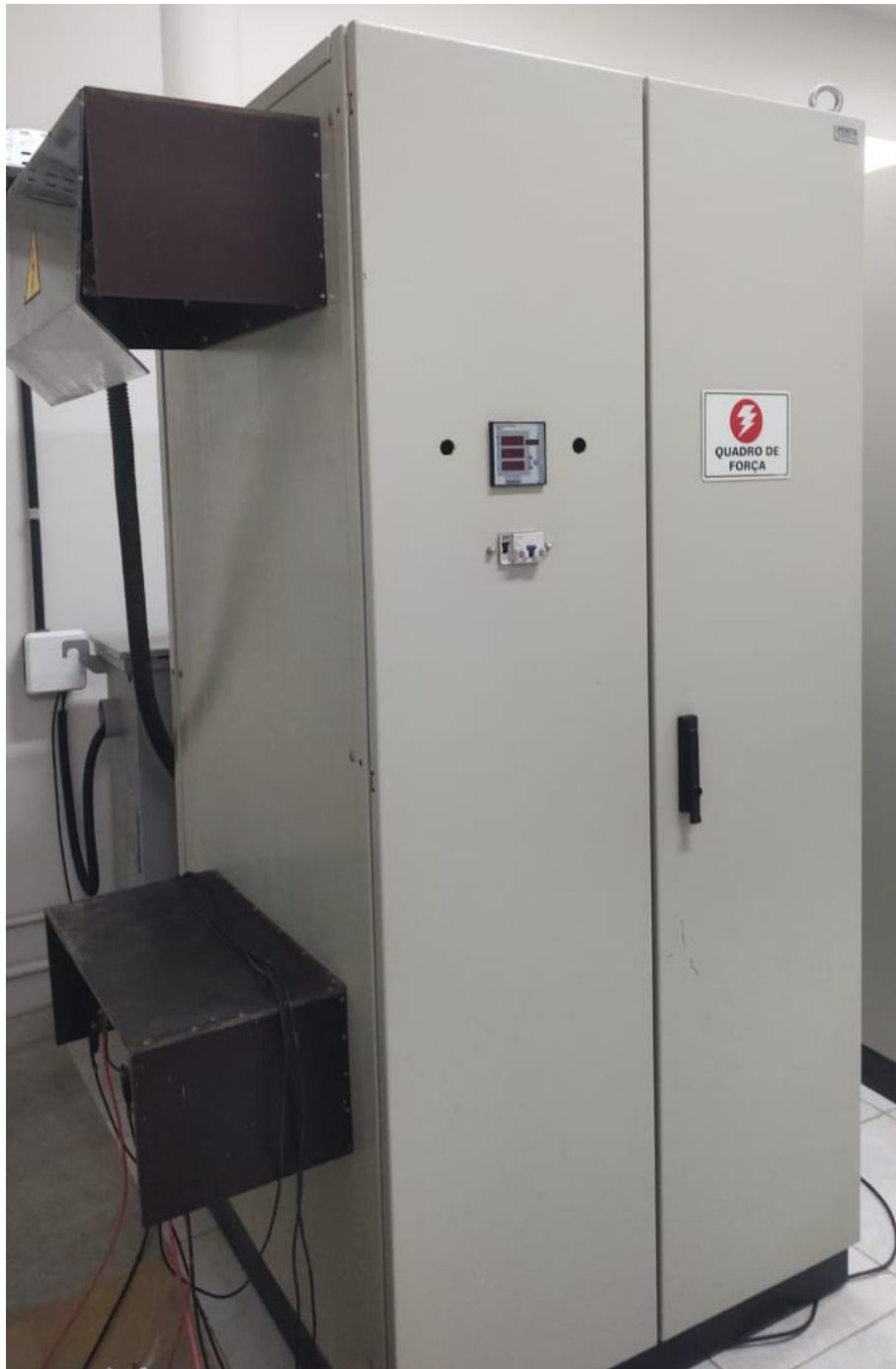
Figura 42 – Cubículo de medição.
