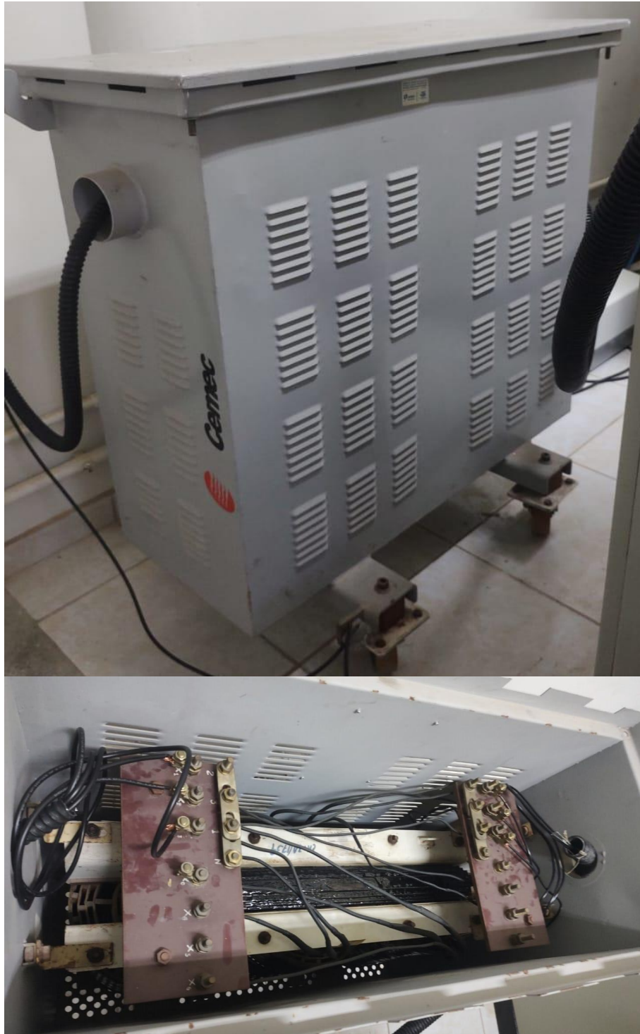
Figura 40 – Transformador a seco.
