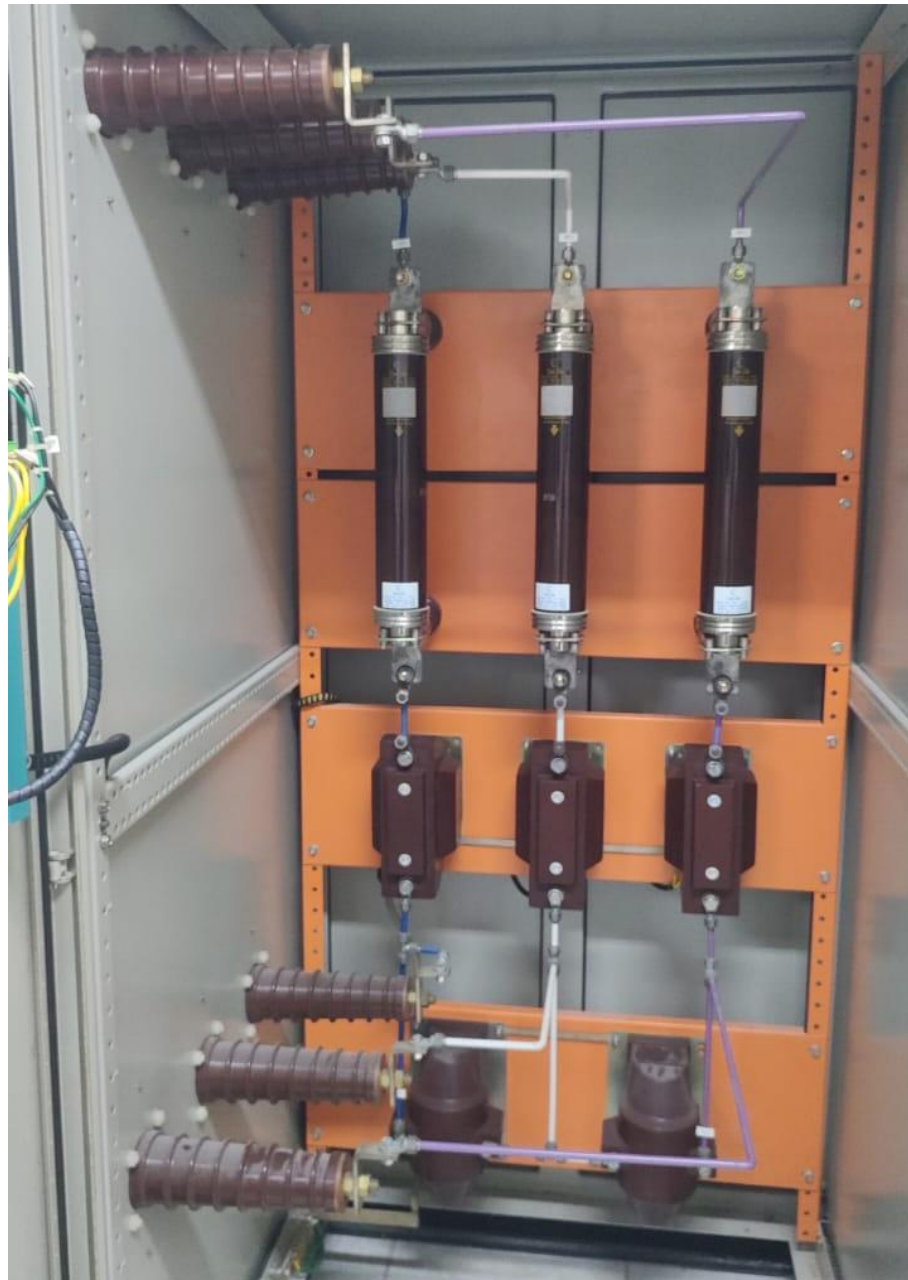
Figura 43 – Cubículo de medição aberto.
