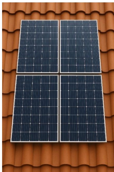
Figura 11 – Layout telha cerâmica com orientação dos módulos em retrato
