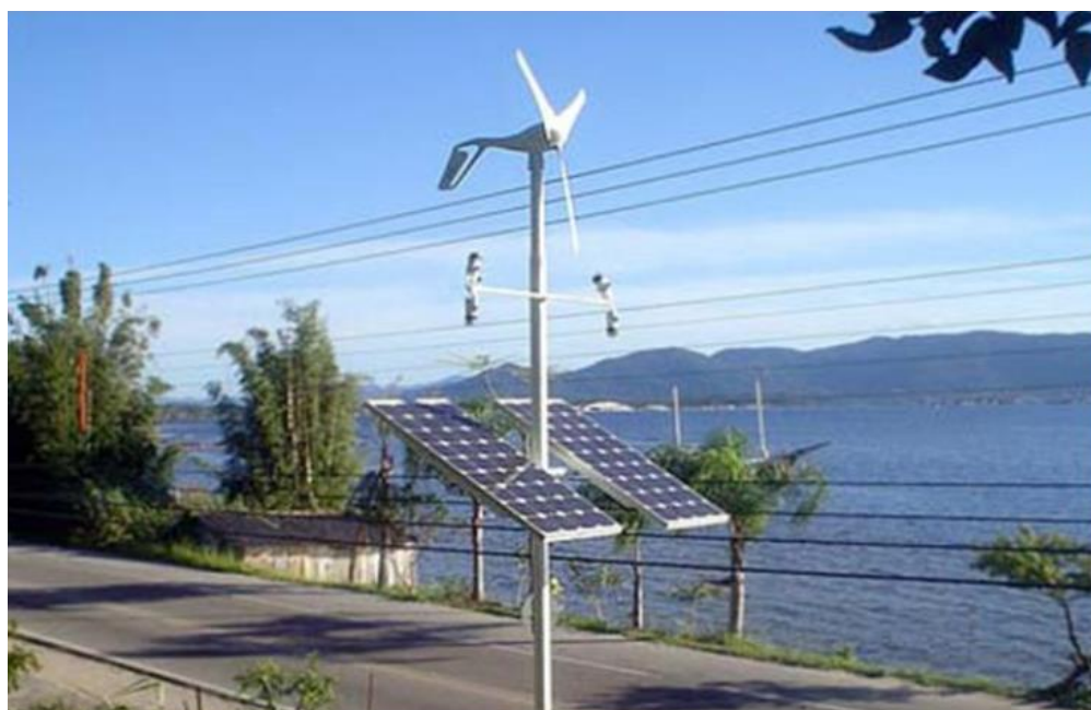
Figura 7 – Sistema híbrido eólico fotovoltaico
