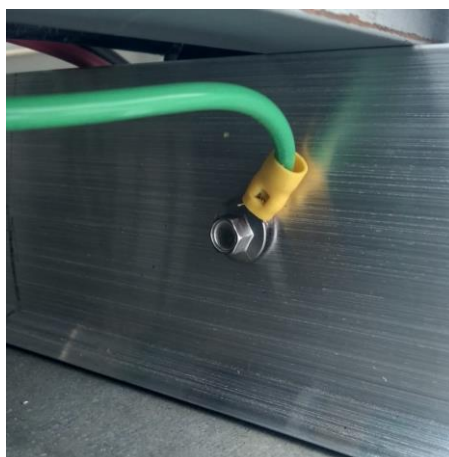
Figura 37 – Detalhe do aterramento da estrutura de fixação.
