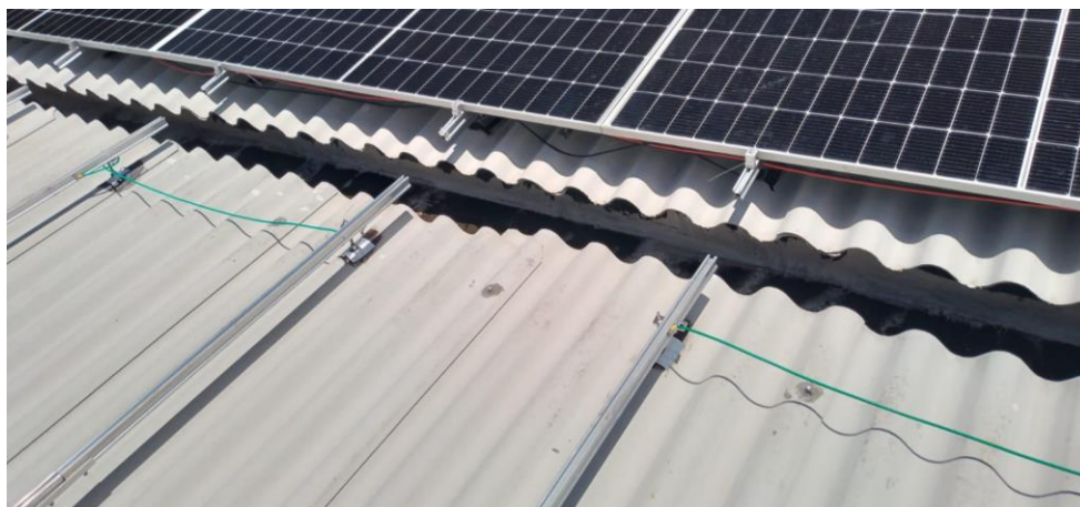
Figura 36 – Aterramento das estruturas metálica de fixação dos módulos fotovoltaicos.
