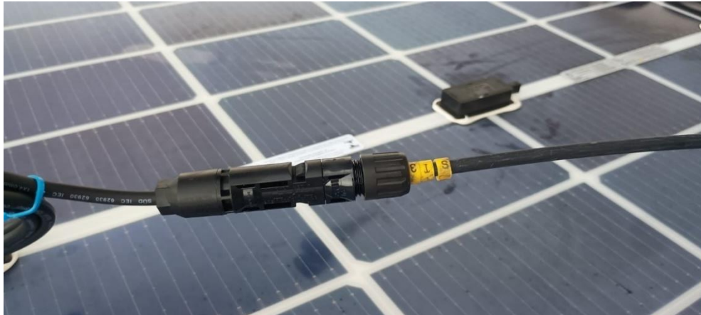
Figura 38 – Crimpagem do conector MC4.
