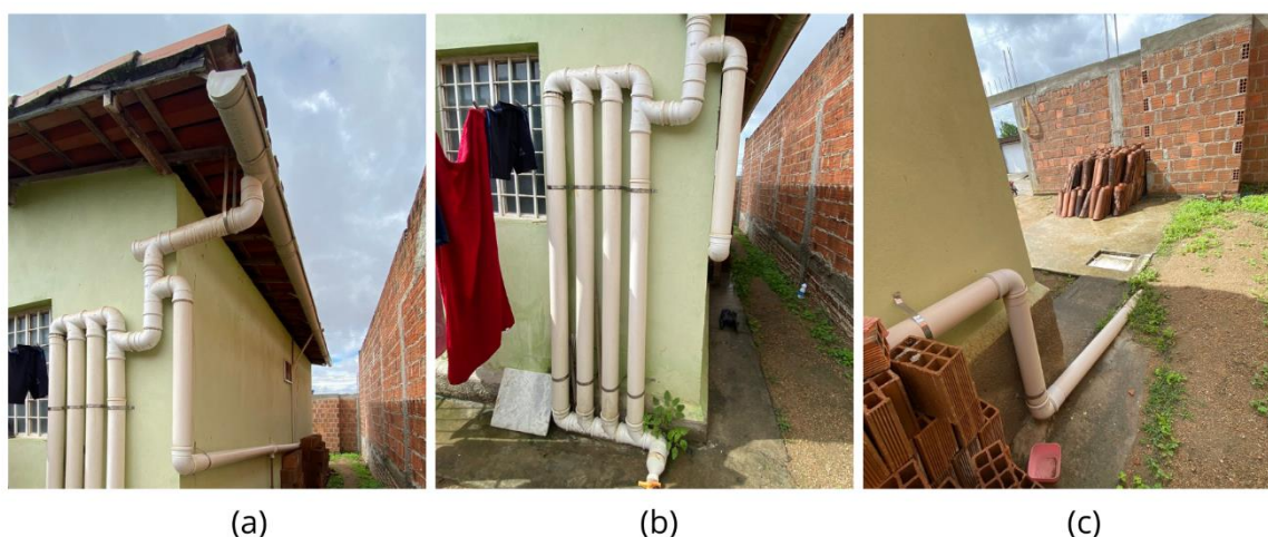
Figura 8- Sistema de captação de água de chuva. (a) calha; (b) DesviUFPE; (c) Encaminhamento a cisterna
