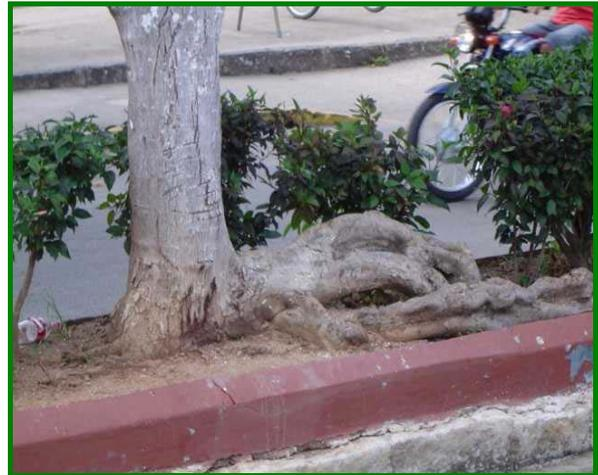
**Fig. 23– Exposição dr raízes, danificando o canteiro Município do Cabo de Sto. Agostinho – PE**
