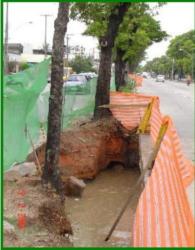
**Fig. 42 – Escavação para passagem do gasoduto (Fátima,M,2004)**
