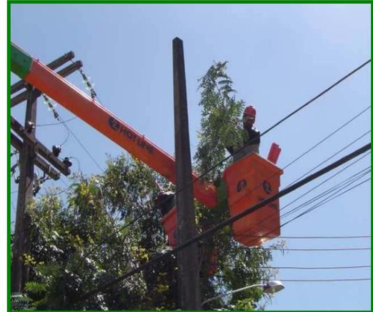
**Fig. 32 - Poda com equipamento adequado com rede desenergizada Recife –PE (FÁTIMA, M. 2004)**
