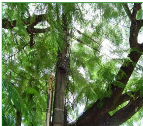
**Fig. 85 – Conflito da arborização x poste e redes. Ausência de poda, redes com espaçadores - Transversal da Av. Pres. Vargas**
