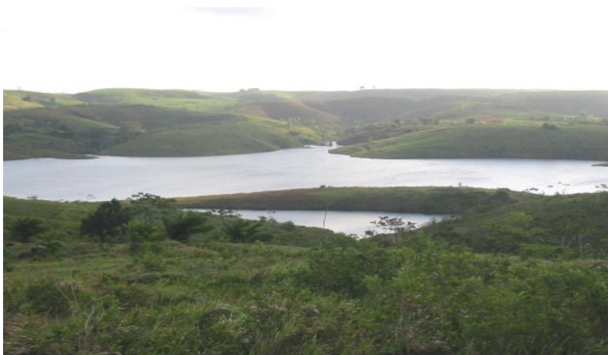
Foto 2.1 – Vista aérea da barragem do rio Pirapama (GADELHA, 2005)
