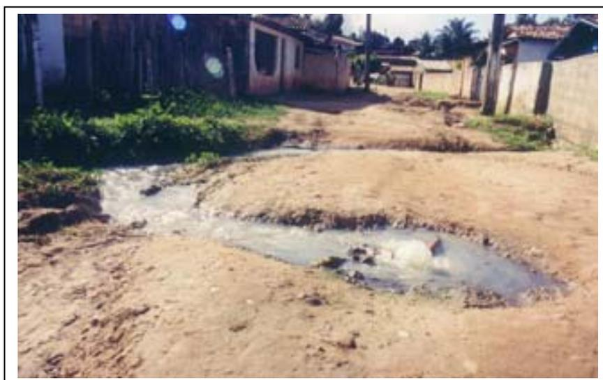
Foto 32 Esgotos estourados pelo excesso de carga
