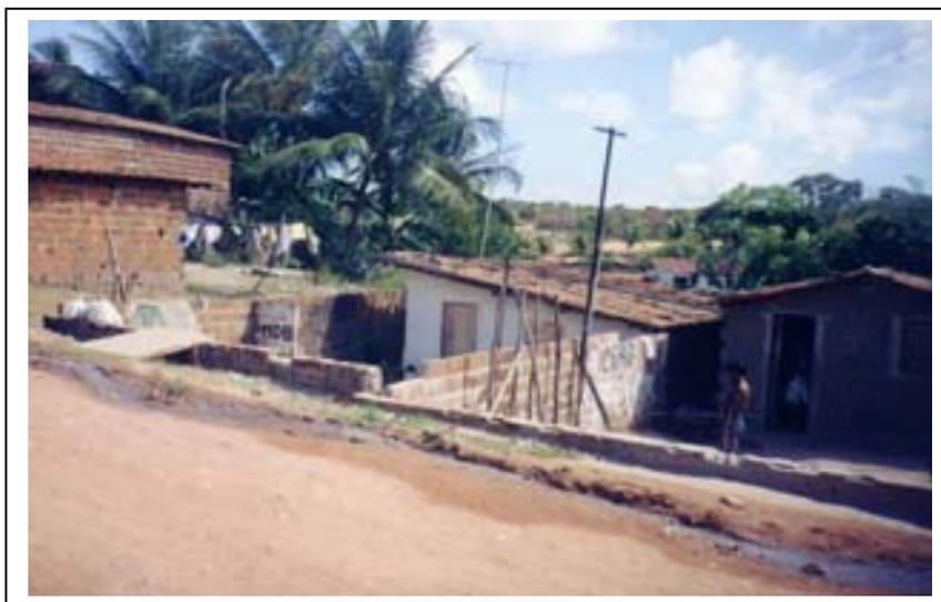
Foto 23 Residências de alvenaria sem reboco
