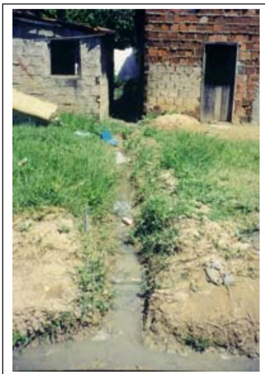
Foto 30 Águas usadas lançadas diretamente em valas escavadas entre os becos que separam os domicílios
