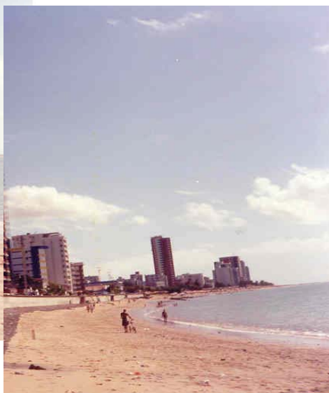
Fotografia 19 – Muro de concreto, Praia de Casa Caiada Olinda (2000).
