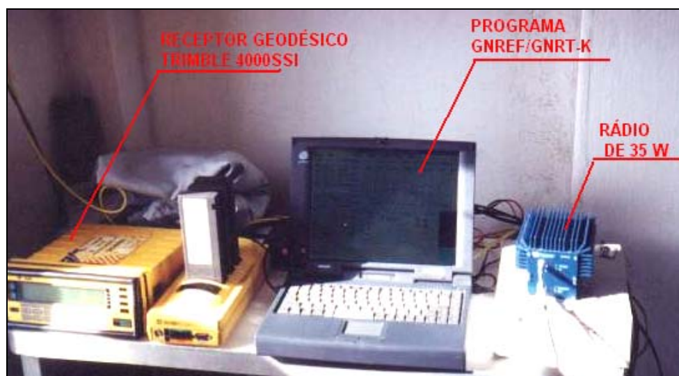
Fotografia 7 – Instalações da Estação 3ª. DL Fonte: KRUEGER (2001)
