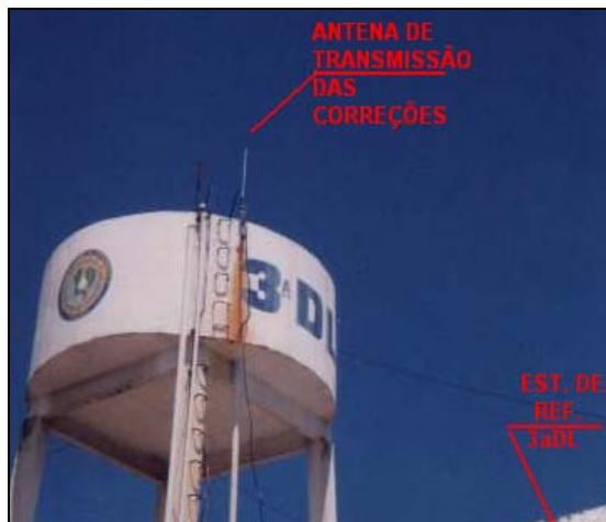
Fotografia 8 – Antena de Transmissão Fonte: KRUEGER (2001)
