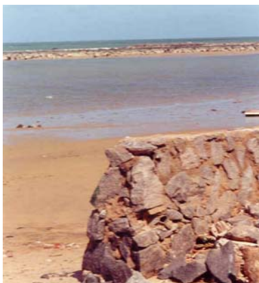
Fotografia 23 – Muro de Blocos de Pedras
