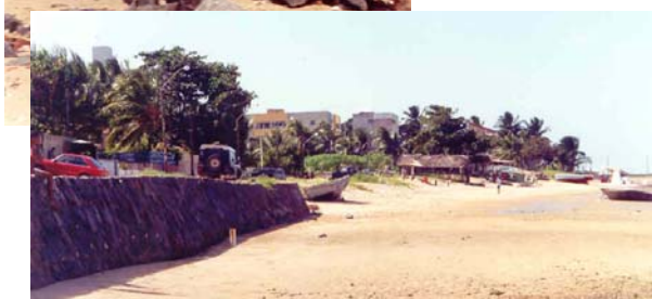
Fotografia 24 – Muro de Blocos de Pedra, na praia de Rio Doce
