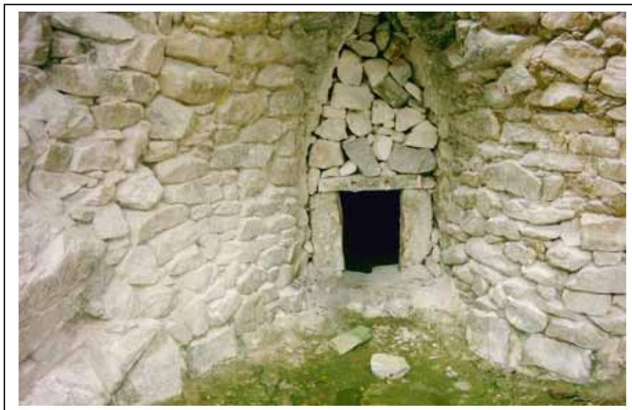
Figura 3 - Forno de calcinação do calcário em Vertente do Lério – PE Fonte: Cunha, 2004
