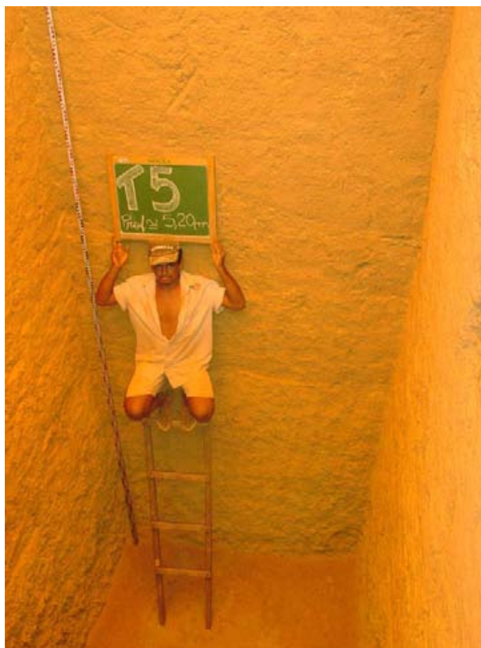
Foto 76: Profundidade da trincheira 5,20m.
