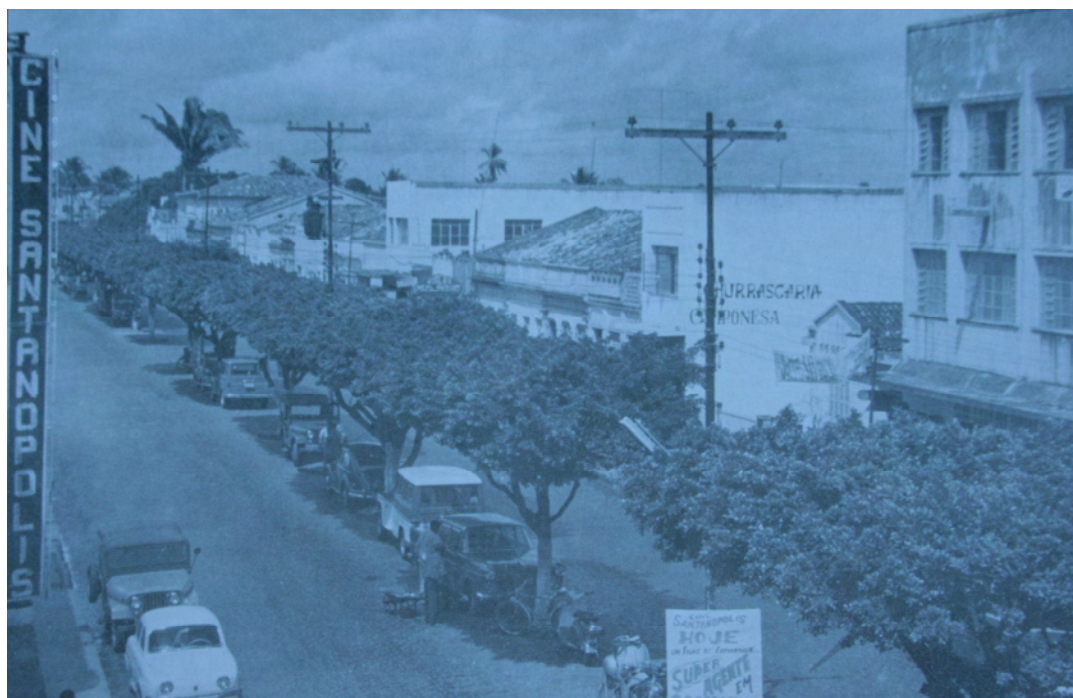
Figura 5 - Avenida Senhor dos Passos. (1967). Em destaque, o canteiro central arborizado. (GAMA, 1994, p.29.)
