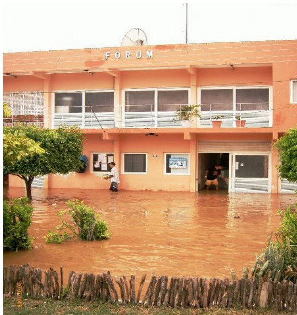
Foto. 8. Até o dia da inundação pela águas do rio Taperoa os processos criminais, cíveis e testamentos, etc. estavam depositados nas salas do térreo do prédio. Funcionários retiram documentação recente.
