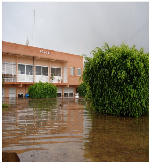
Foto. 8. Do lado esquerdo, próximo a árvore, fica a porta para do depósito onde ficava os processos criminais por mim pesquisados. Os mesmos foram retirados antes da inundação.
