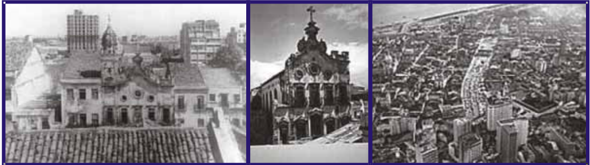
Fig. 8. Etapas da demolição da Igreja dos Martírios e abertura da Av. Dantas Barreto.
