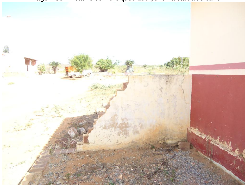
Imagem 36 – Detalhe do muro quebrado por uma batida de carro
