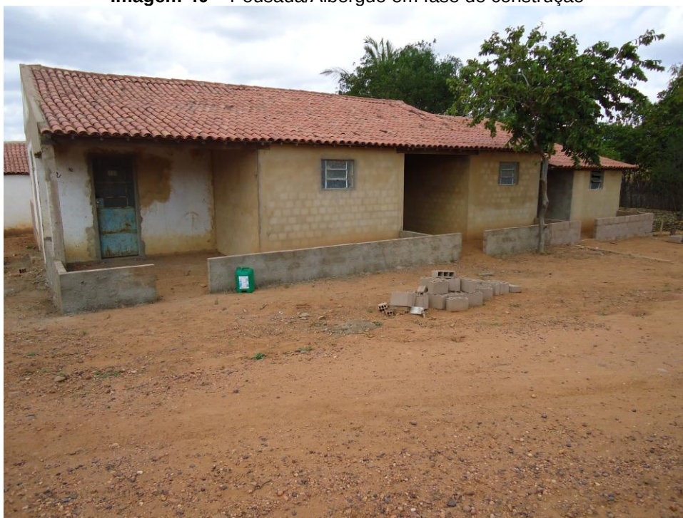
Imagem 40 – Pousada/Albergue em fase de construção
