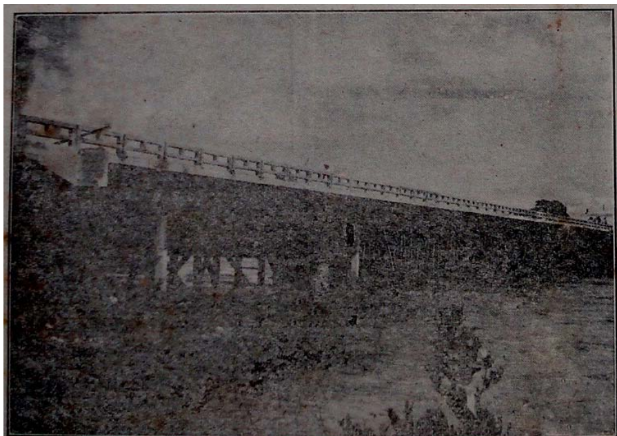
Fotografia 07. Ponte dos Trabalhadores.
