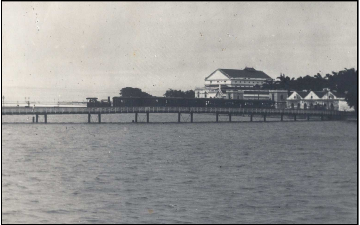
Ponte da Maxambomba - Ligava Santo Antônio a Boa Vista. Nela uma das composições da Brazilian Street Railway Company.
