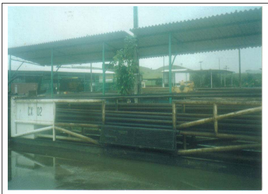
Figura 11 Dutos armazenados no pátio da instalação em Saquinho
