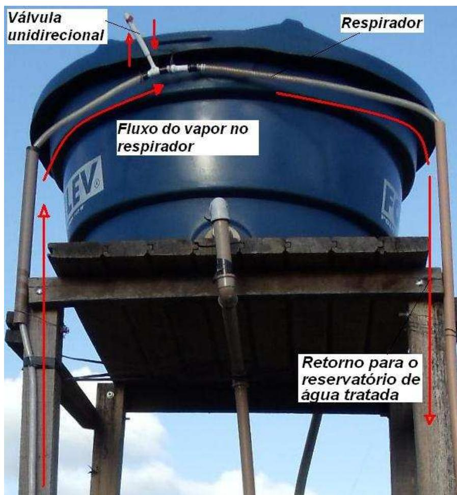
**Figura 22. Circulação de retorno do vapor no respirador.**
